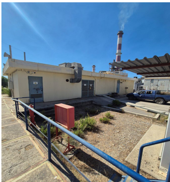
Εικόνα 4: Ανατολική πλευρά κτιρίου
