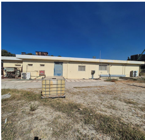
Εικόνα 1: Δυτική πλευρά κτιρίου
