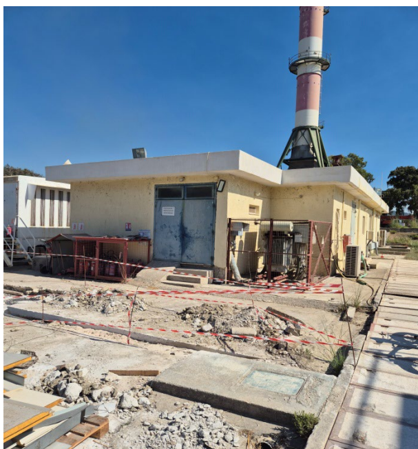
Εικόνα 3: Βόρεια πλευρά κτιρίου
