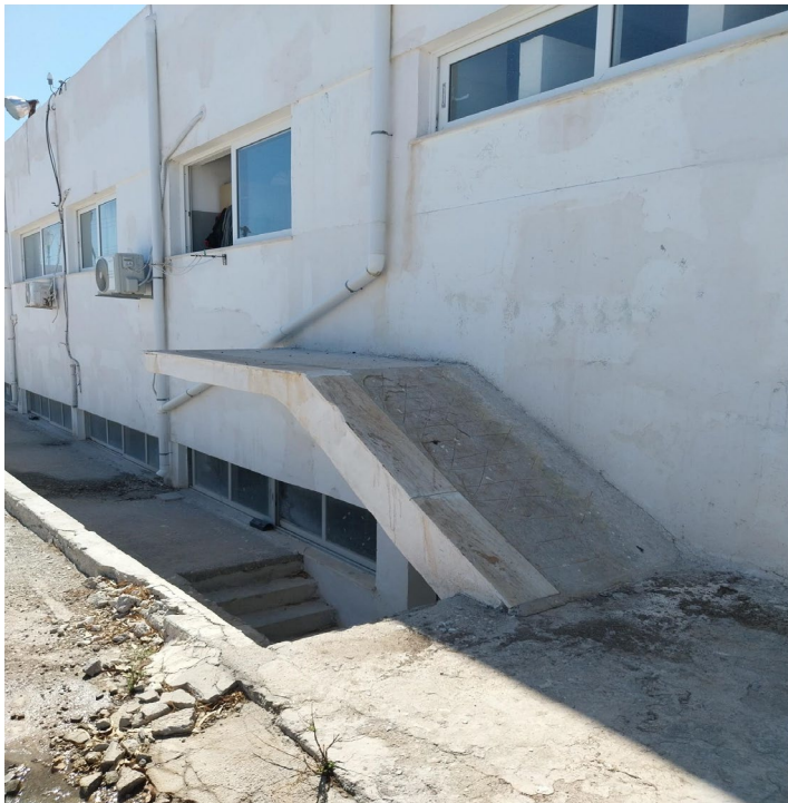
Εικόνα 6: Ράμπα πλευρικά του κτιρίου
