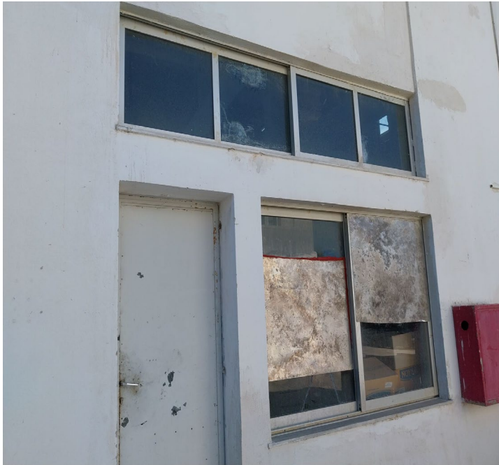
Εικόνα 3: Θύρα εισόδου και υαλοστάσιο στη βόρεια πλευρά
