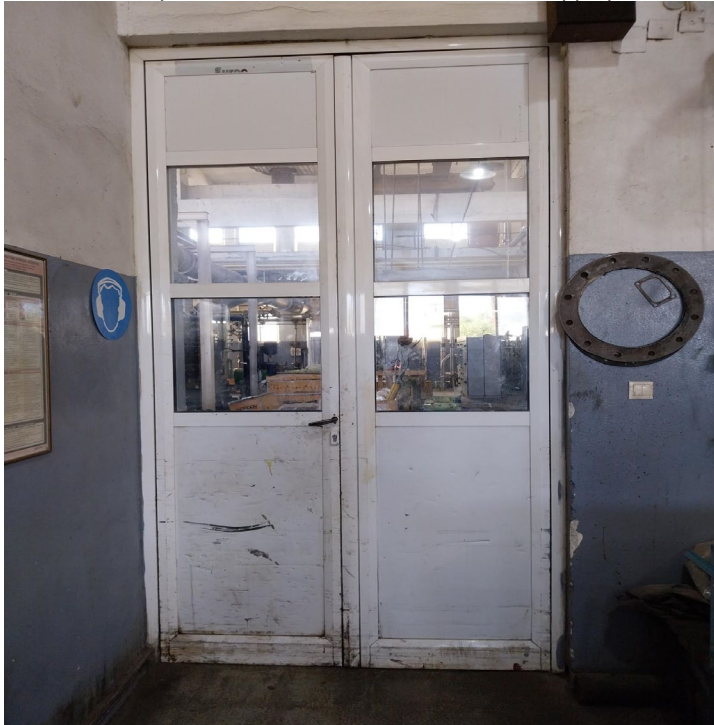
Εικόνα 4: Θύρα εισόδου από το μηχανουργείο στο μηχανοστάσιο
