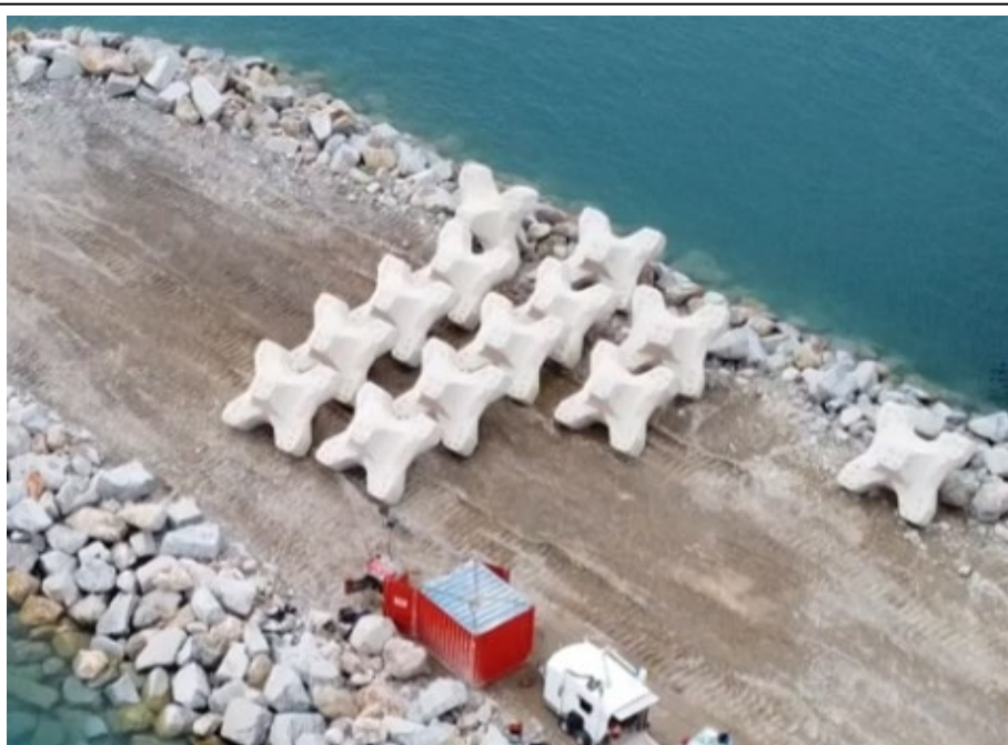
Εικόνα 11 : Κατασκευασμένα ακρόποδα
