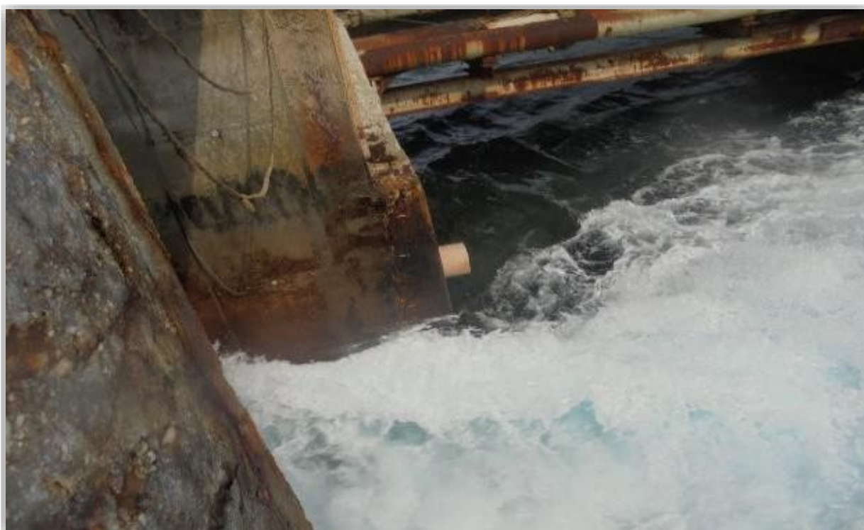
Εικόνες 4 & 5 : Κατάσταση γέφυρας
