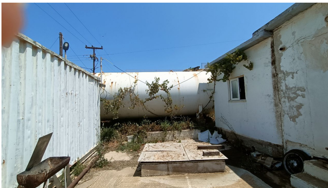
Εικόνα 25 Άποψη βοηθητικού κτίσματος για επισκευαστικές εργασίες και χρωματισμό.
