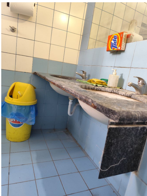
Εικόνα 18 Άποψη χώρων υγιεινής προς αναβάθμιση.
