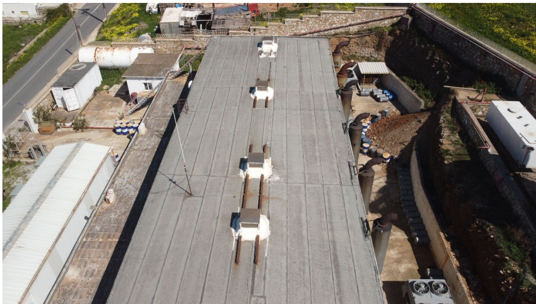
Εικόνα 6 Υφιστάμενη κατάσταση οροφής κτιρίου Μηχανοστασίου. Ενίσχυση υφιστάμενης υγρομόνωσης.
