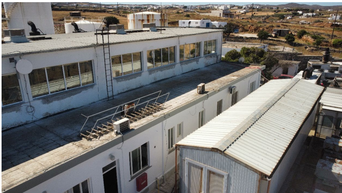
Εικόνα 7 Υφιστάμενη κατάσταση οροφής βοηθητικών Μηχανοστασίου. Πλήρης αποξήλωση υφιστάμενης κατάστασης και κατασκευή νέας στρώσης αντεστραμμένης θερμουγρομόνωσης.
