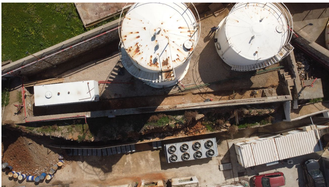
Εικόνα 11 Πανοραμική άποψη και των δύο θέσεων κατασκευής κυκλιδωμάτων προστασίας για εξοπλισμό πυρόσβεσης.
