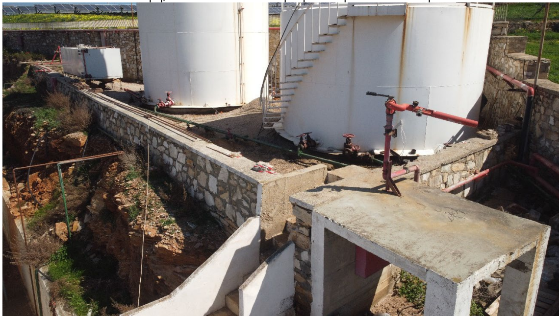
Εικόνα 9 Θέση κατασκευής κιγκλιδώματος προστασίας 1ης; πλατφόρμας εγκατάστασης εκτοξευτήρα νερού (κανονάκι) πυρόσβεσης.
