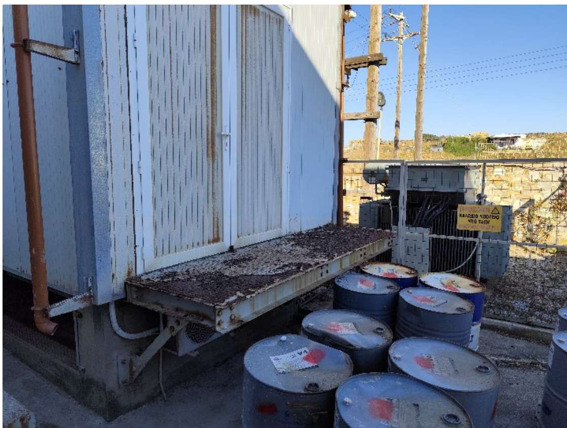
Εικόνα 15 Θέση κατασκευής κιγκλιδώματος προστασίας και αντικατάσταση μπακλαδωτής λαμαρίνας πλατύσκαλου με σχαρωτό δάπεδο.
