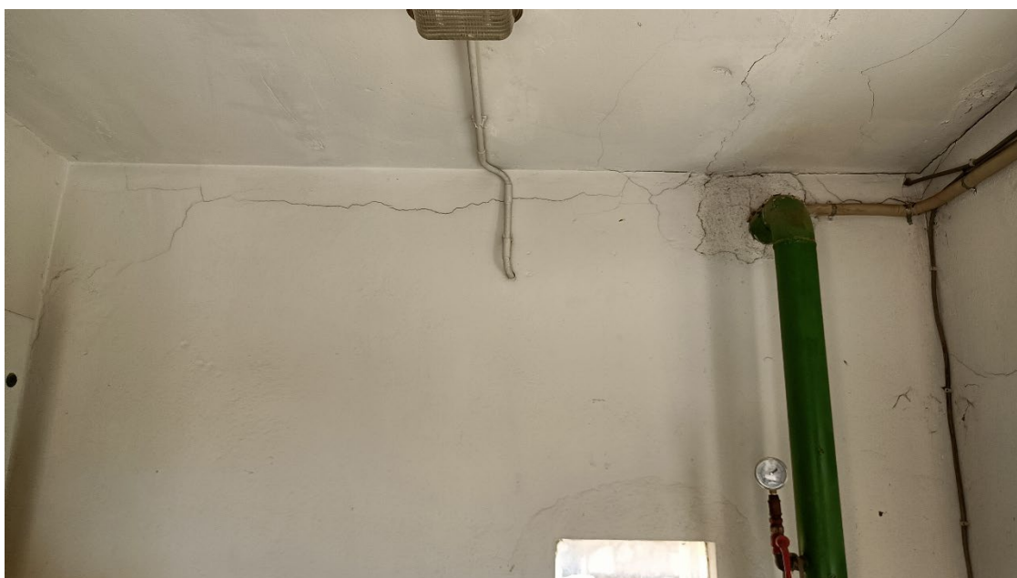
Εικόνα 24 Άποψη βοηθητικού κτίσματος για επισκευαστικές εργασίες και χρωματισμό.
