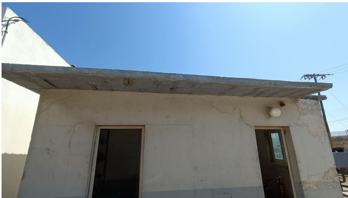
Εικόνα 21 Άποψη βοηθητικού κτίσματος για επισκευαστικές εργασίες και χρωματισμό.
