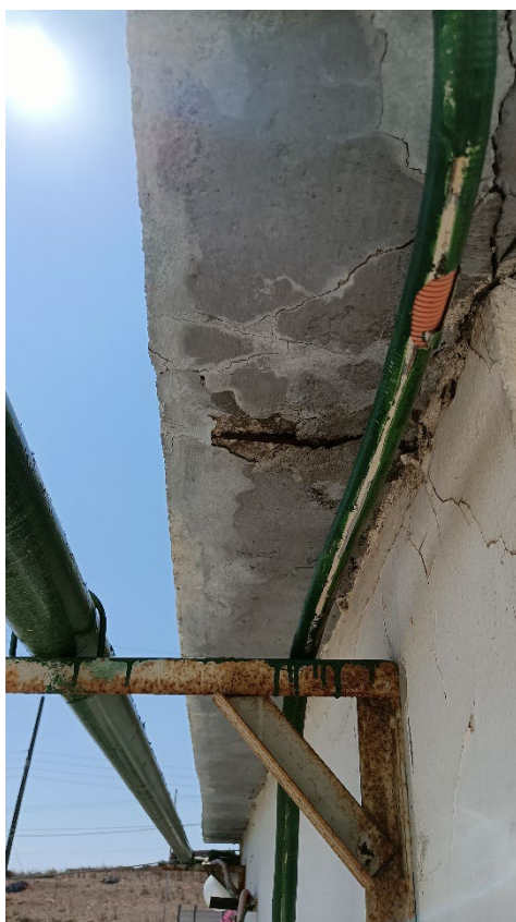
Εικόνα 22 Άποψη βοηθητικού κτίσματος για επισκευαστικές εργασίες και χρωματισμό.
