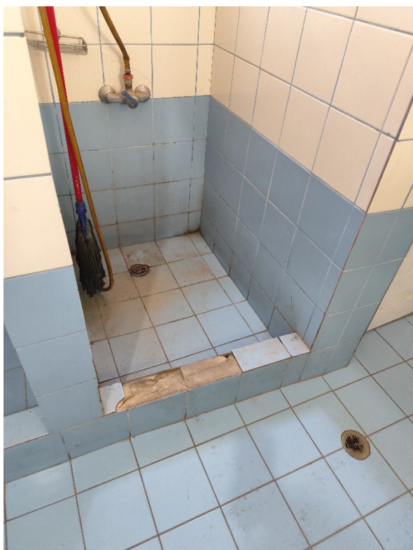
Εικόνα 17 Αποψη χώρων υγιεινής προς αναβάθμιση.
