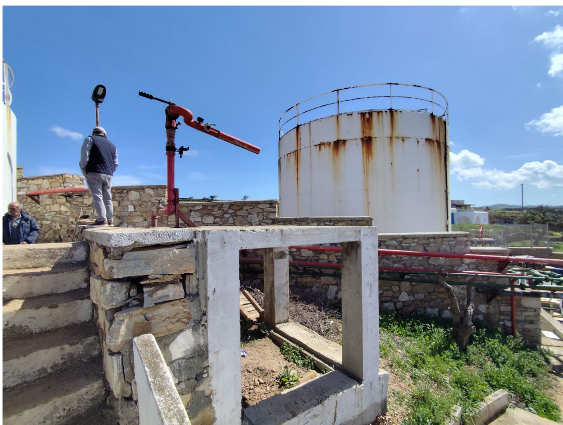
Εικόνα 10 Θέση κατασκευής κιγκλιδώματος προστασίας 1ης; πλατφόρμας εγκατάστασης εκτοξευτήρα νερού (κανονάκι) πυρόσβεσης.
