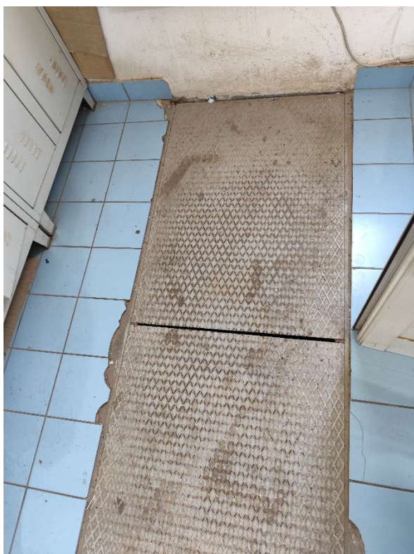
Εικόνα 20 Αποψη χώρων υγιεινής προς αναβάθμιση.
