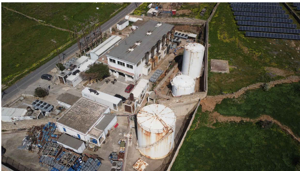
Εικόνα 4 Πανοραμική άποψη της εγκατάστασης του ΤΣΠ Κύθνου.
