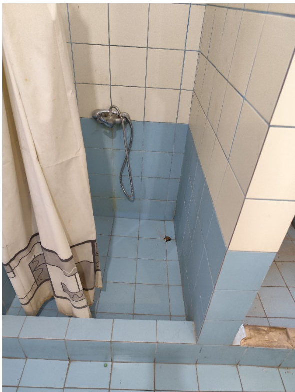
Εικόνα 16 Αποψη χώρων υγιεινής προς αναβάθμιση.
