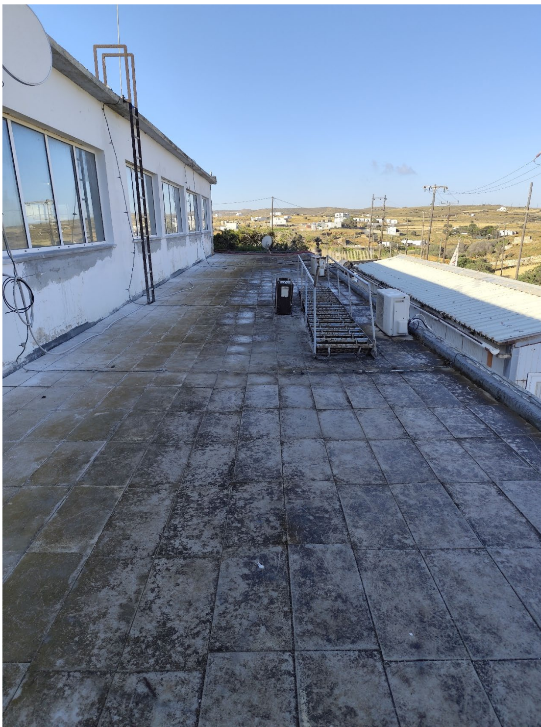
Εικόνα 8 Κοντινότερη άποψη υφιστάμενης κατάστασης οροφής βοηθητικών Μηχανοστασίου. Πλήρης αποξήλωση υφιστάμενης κατάστασης και κατασκευή νέας στρώσης αντεστραμμένης θερμοαπομονώσεως.
