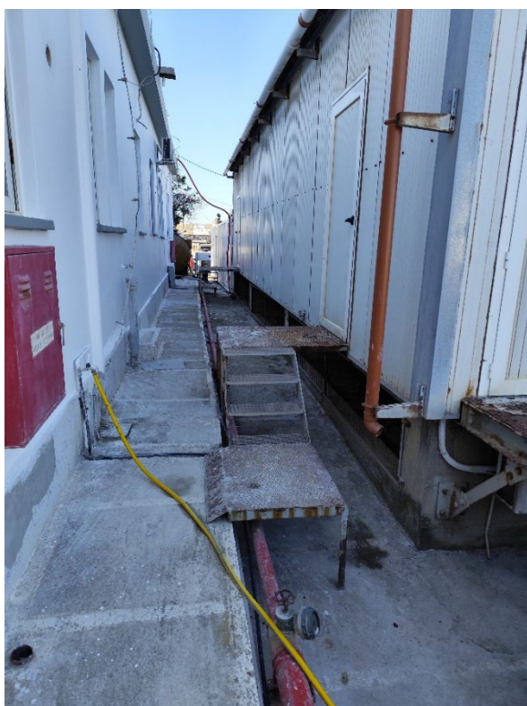
Εικόνα 14 Θέση κατασκευής κιγκλιδώματος προστασίας 1 ης και 2 ης κλίμακας και πλατύσκαλου εισόδου στο Isobox.
