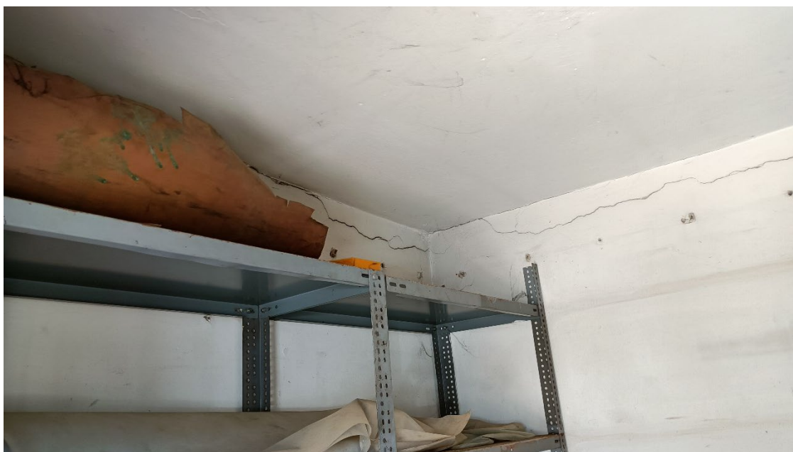
Εικόνα 23 Άποψη βοηθητικού κτίσματος για επισκευαστικές εργασίες και χρωματισμό.
