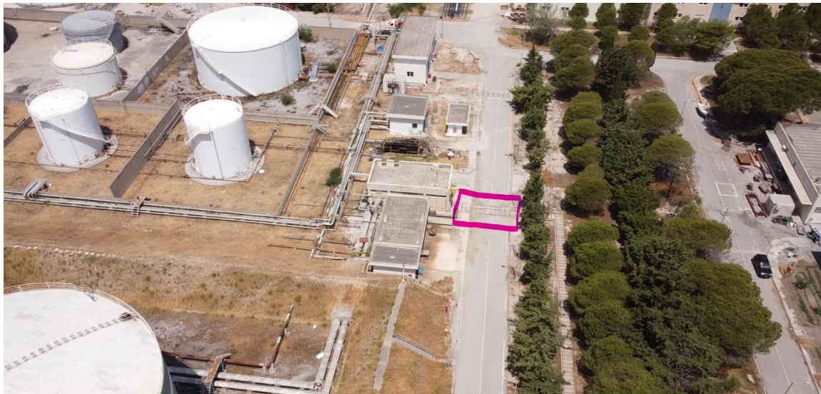
Εικόνα 1 Αεροφωτογραφία, περιοχή αντικατάστασης αιρετών πλακών ΗΜ καναλιού του ΑΗΣ Σορωνής [προ της εγκατάστασης γεφυροπλάστιγγας].
