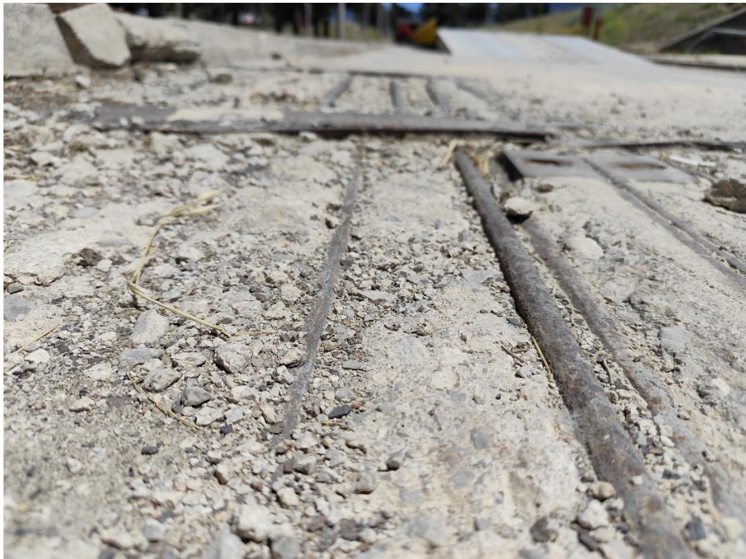
Εικόνα 5 Κοντινότερη άποψη ενός ηλεκτρομηχανολογικού καναλιού και των αιρετών πλακών.
