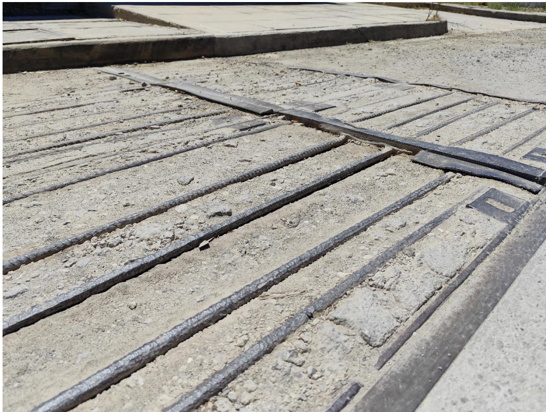
Εικόνα 6 Κοντινότερη άποψη ενός ηλεκτρομηχανολογικού καναλιού και των αιρετών πλακών.
