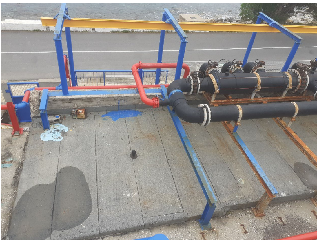
Φωτογραφία 63 Άποψη υγρομονώσεων πλάκας οροφής αντλιοστασίου θάλασσας.
