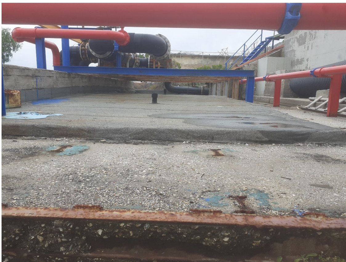
Φωτογραφία 65 Αποψη υγραμονώσεων πλάκας οροφής αντλιοστασίου θάλασσας.
