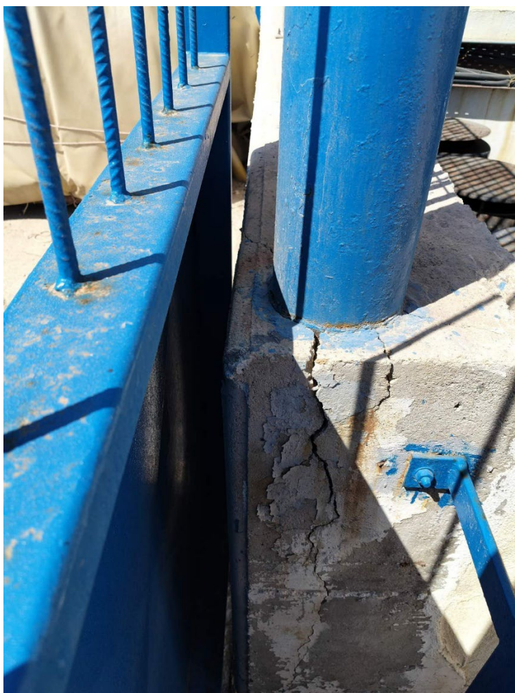
Φωτογραφία 38 Άποψη στοιχείων σκυροδέματος φρεατίου άντλησης [2] τρίδημου αντλητικού ζεύγους 420m 3 /h.
