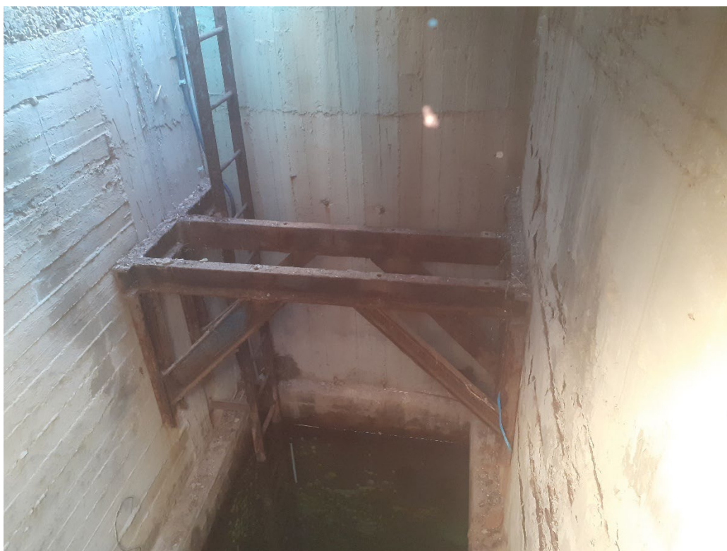
Φωτογραφία 30 Αποψη βοηθητικής κατασκευής (τμήμα 1γ) καθώς και κατακόρυφης κλίμακας φρεατίου ηρεμίας και φύκων [1].
