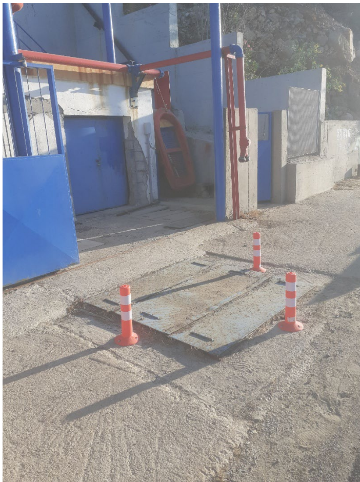
Φωτογραφία 45 Θέση ενδιάμεσου φρεατίου [4].
