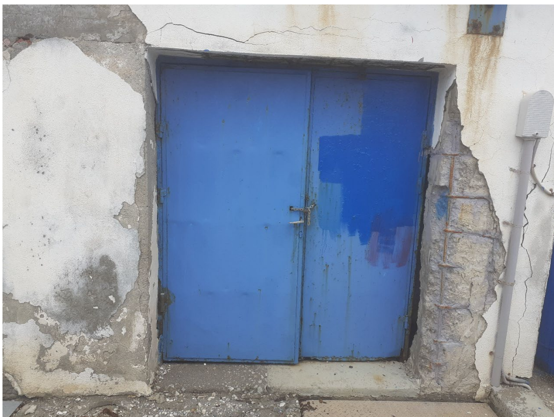
Φωτογραφία 54 Άποψη μεταλλικής θύρας και κατάστασης στοιχείων σκυροδέματος νότιας όψης του αντλιοστασίου θάλασσας.
