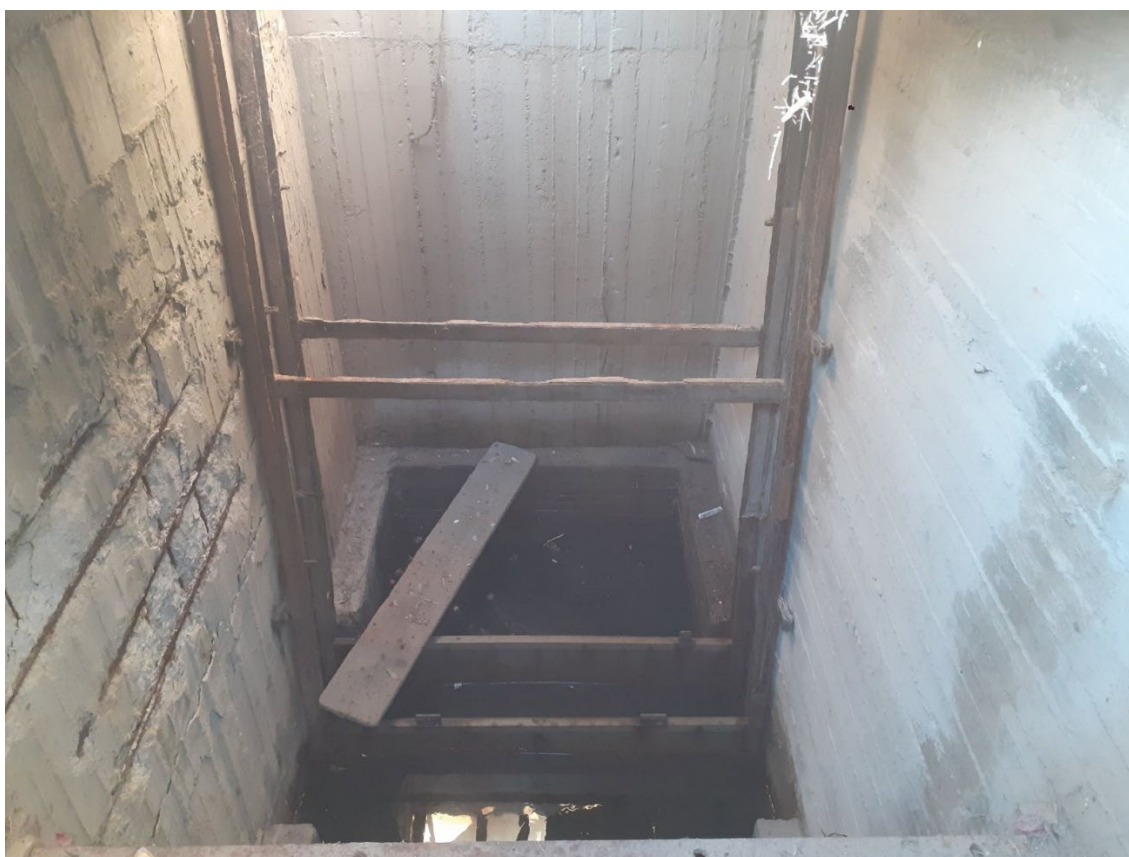
Φωτογραφία 21 Αποψη διάταξης του συστήματος φίλτρων φρεατίου ηρεμίας και φύκων [1].
