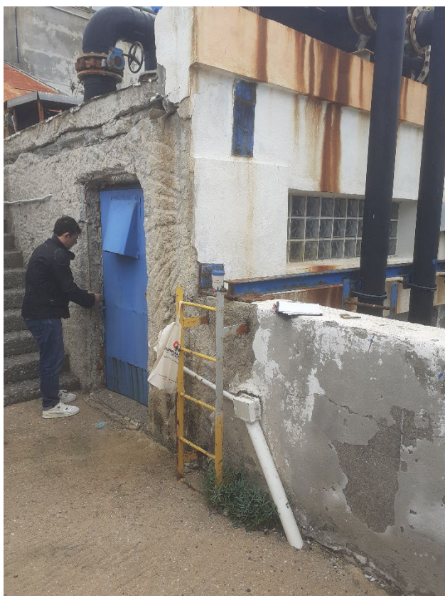
Φωτογραφία 52 Άποψη δυτικής όψης και μεταλλικής θύρας του αντλιοστασίου θάλασσας.
