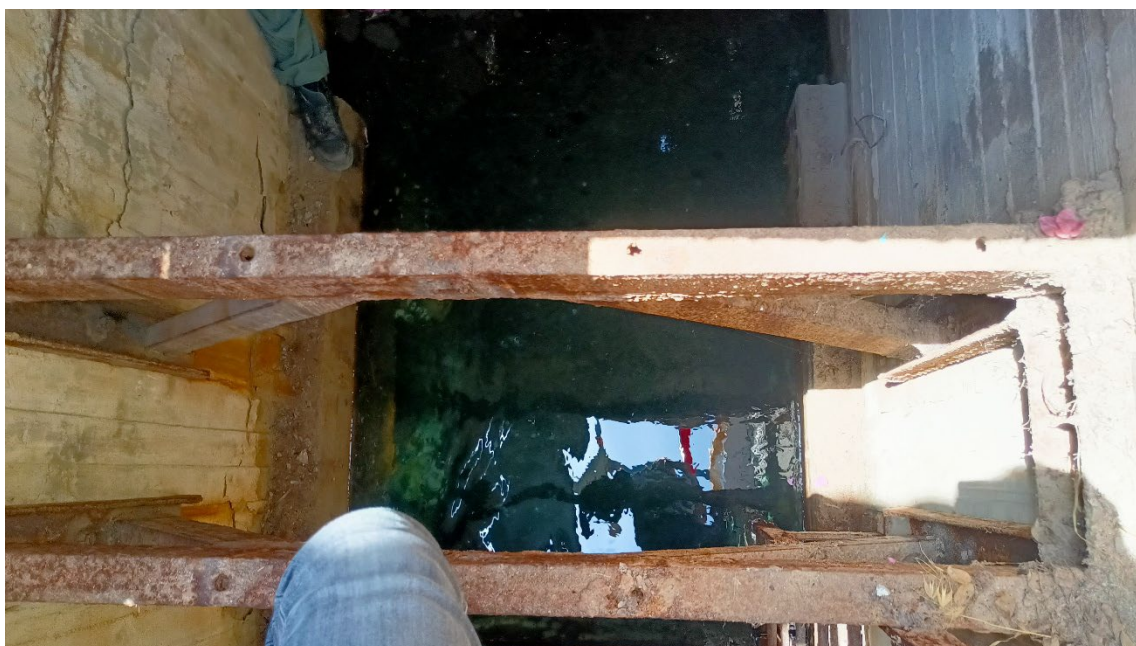
Φωτογραφία 29 Άποψη βοηθητικής κατασκευής τοποθέτησης αντλητικού συγκροτήματος (τμήμα 1γ) φρεατίου ηρεμίας και φύκων [1].
