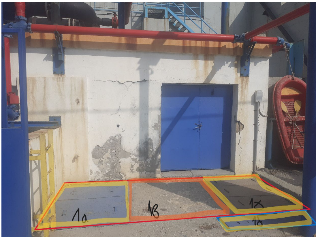
Φωτογραφία 6 Άποψη οροφής φρεατίου ηρεμίας και φύκων - επεξήγηση ανοιγμάτων.
