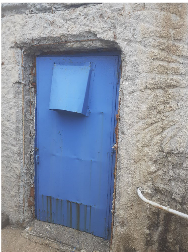
Φωτογραφία 53 Άποψη μεταλλικής θύρας δυτικής όψης του αντλιοστασίου θάλασσας.
