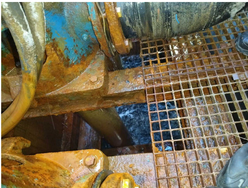
Φωτογραφία 36 Άποψη κατάστασης μεταλλικής κατασκευής στήριξης τρίδημου αντλητικού ζεύγους 420m 3 /h. Διακρίνεται η γραδελάδα διαμόρφωσης δαπέδου εργασίας, εντός φρεατίου [2]
