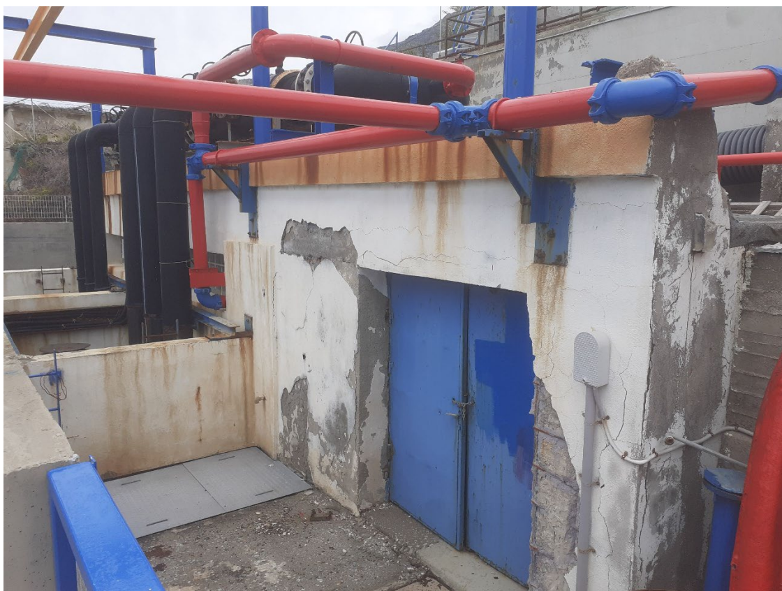
Φωτογραφία 55 Άποψη μεταλλικής θύρας και κατάστασης στοιχείων σκυροδέματος νότιας όψης του αντλιοστασίου θάλασσας.
