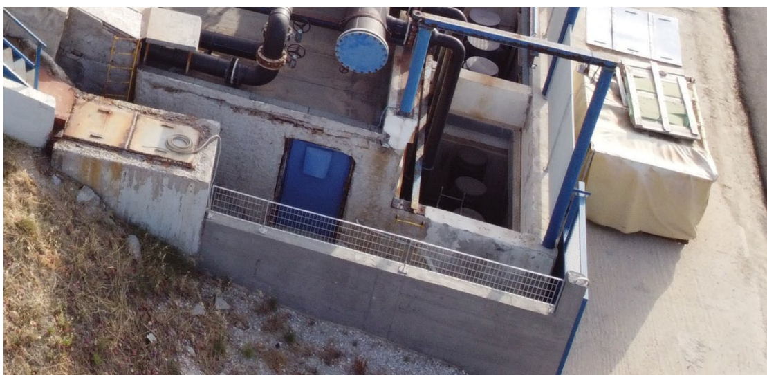
Φωτογραφία 51 Αεροφωτογραφία - Άποψη δυτικής όψης και οροφής του αντλιοστασίου θάλασσας.
