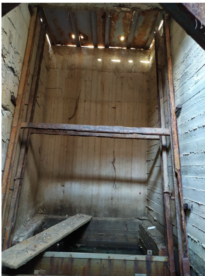
Φωτογραφία 22 Αποψη διάταξης του συστήματος φίλτρων φρεατίου ηρεμίας και φύκων [1]. Διακρίνεται η «πατούρα» στη θέση +0,50m για την κατασκευή δαπέδου εργασίας.
