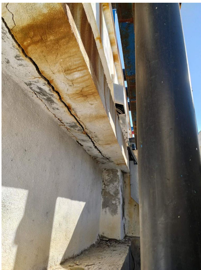
Φωτογραφία 43 Άποψη στοιχείων σκυροδέματος φρεατίου άντλησης [3] τρίδημου αντλητικού ζεύγους 260m 3 /h.
