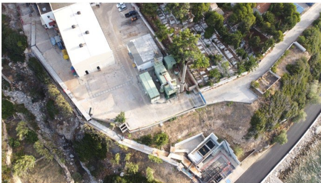
Φωτογραφία 18 Αεροφωτογραφία, περιοχή του ΤΣΠ Ικαρίας. Περιοχή φρεατίων θάλασσας και αντλιοστασίου.
