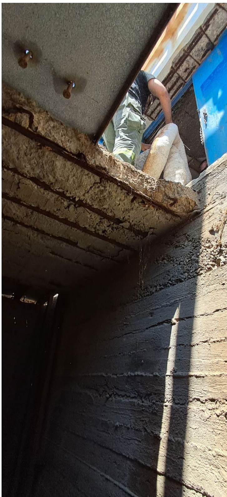
Φωτογραφία 27 Κοντινή άποψη κατάστασης σιδηρού οπλισμού και σκυροδέματος οροφής (τμήμα 1β) φρεατίου ηρεμίας και φύκων [1].
