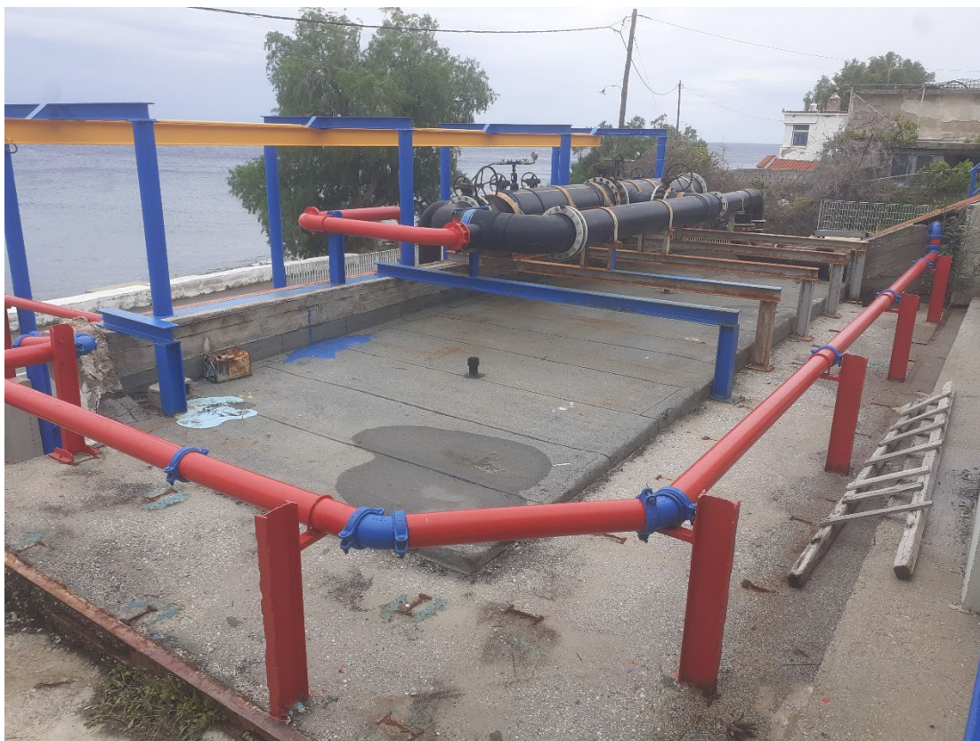
Φωτογραφία 64 Άποψη υγρομονώσεων πλάκας οροφής αντλιοστασίου θάλασσας.
