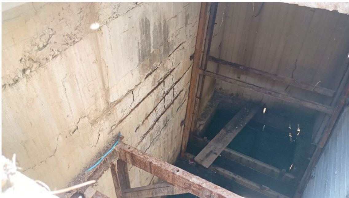
Φωτογραφία 20 Απόψεις τοιχίων φρεατίου ηρεμίας και φύκων και φίλτρων [1].
