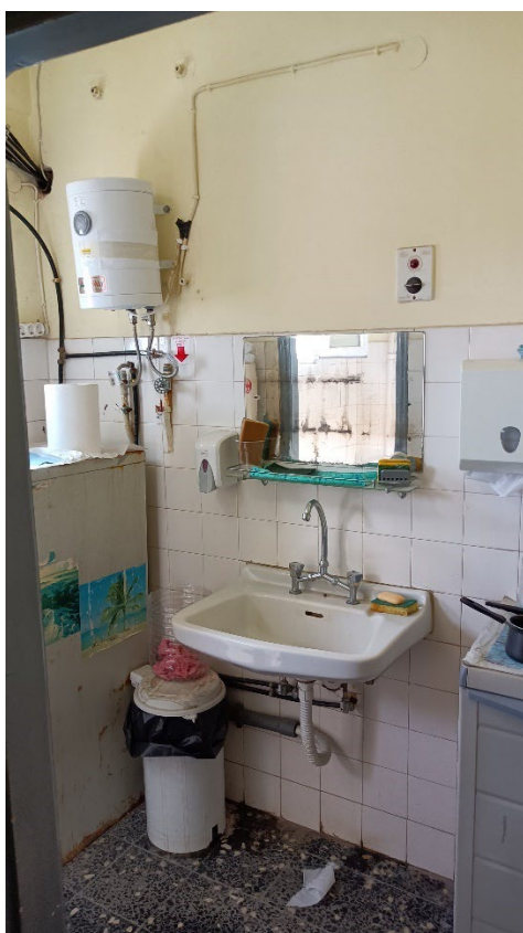
Εικόνα 35 Εσωτερική άποψη υφιστάμενου χώρου WC του κτιρίου γραφείων διοίκησης, κτίριο 5.
