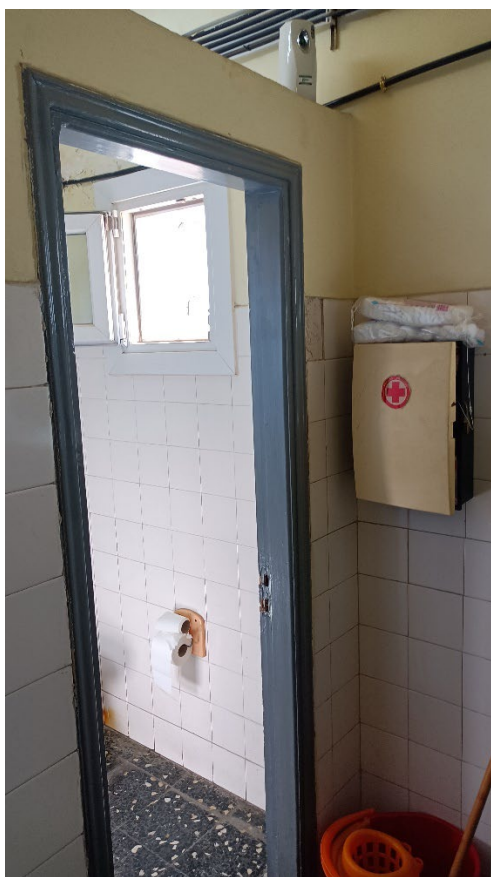
Εικόνα 36 Εσωτερική άποψη υφιστάμενου χώρου WC του κτιρίου γραφείων διοίκησης, κτίριο 5.
