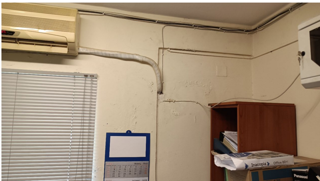
Εικόνα 31 Εσωτερική άποψη χώρων του κτιρίου γραφείων διοίκησης, κτίριο 5.
