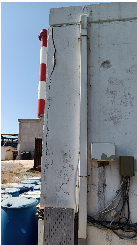
Εικόνα 22 Άποψη από εξωτερικά περιμετρικά στοιχεία όψης του κτιρίου γραφείων διοίκησης, κτίριο 5.
