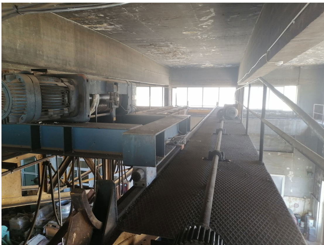
Εικόνα 20 Αποψη τμημάτων οροφής από το επίπεδο της γερανογέφυρας του Μηχανοστασίου, κτίριο Α.
