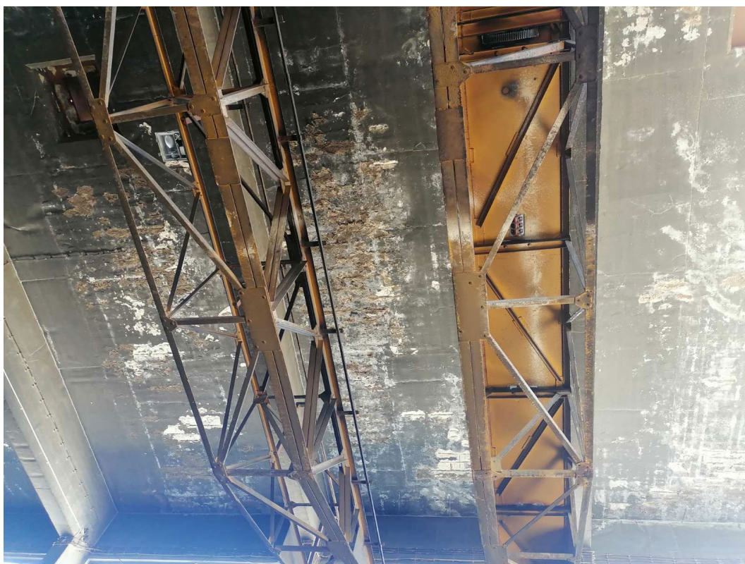
Εικόνα 5 Εσωτερική άποψη διαφόρων τμημάτων της κάτω παρειάς πλάκας οροφής ισογείου Μηχανοστασίου, κτίσμα Α.
