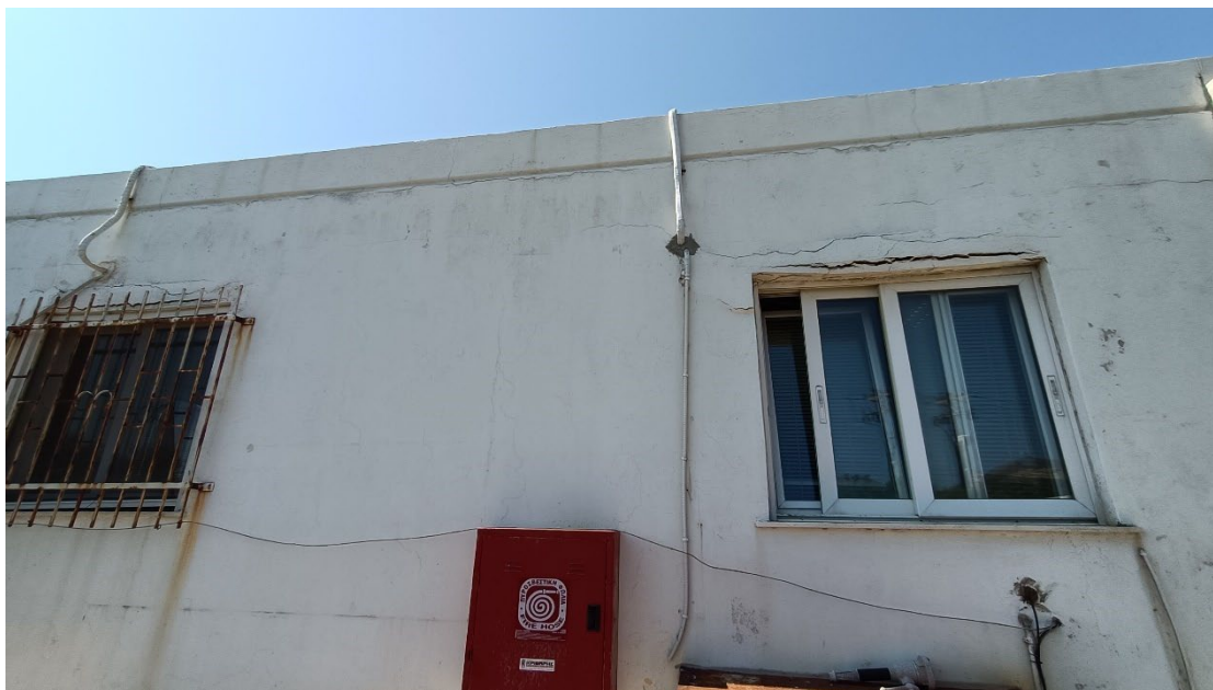
Εικόνα 24 Αποψη από εξωτερικά περιμετρικά στοιχεία όψης του κτιρίου γραφείων διοίκησης, κτίριο 5.
