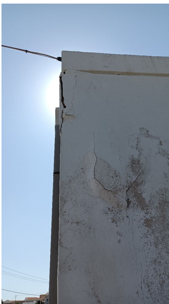
Εικόνα 25 Αποψη από εξωτερικά περιμετρικά στοιχεία όψης του κτιρίου γραφείων διοίκησης, κτίριο 5.
