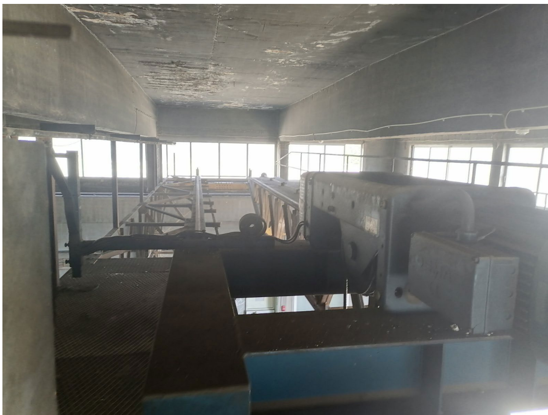
Εικόνα 19 Άποψη τμημάτων οροφής από το επίπεδο της γερανογέφυρας του Μηχανοστασίου, κτίριο Α.
