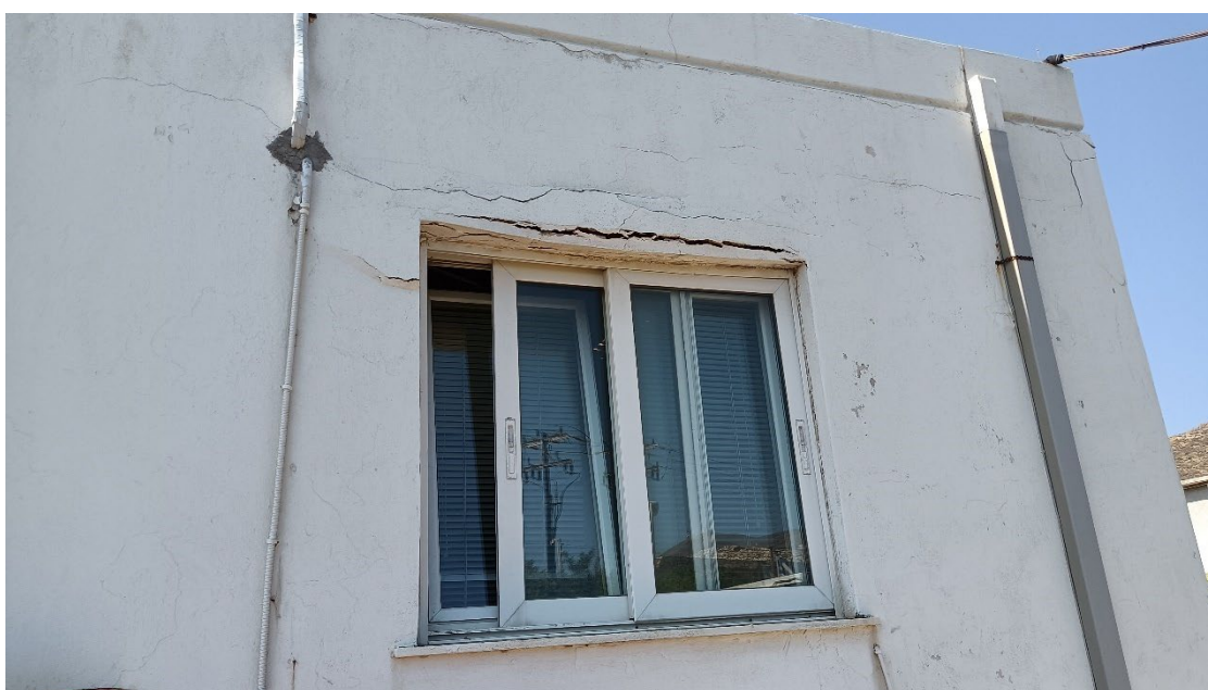
Εικόνα 23 Άποψη από εξωτερικά περιμετρικά στοιχεία όψης του κτιρίου γραφείων διοίκησης, κτίριο 5.
