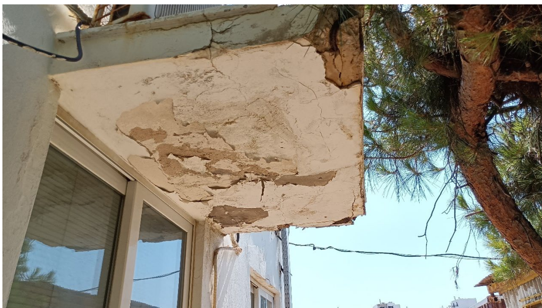
Εικόνα 30 Άποψη από εξωτερικά περιμετρικά στοιχεία όψης του κτιρίου γραφείων διοίκησης, κτίριο 5.
