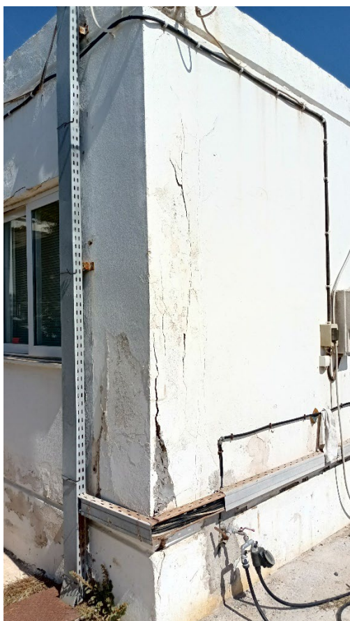
Εικόνα 27 Αποψη από εξωτερικά περιμετρικά στοιχεία όψης του κτιρίου γραφείων διοίκησης, κτίριο 5.
