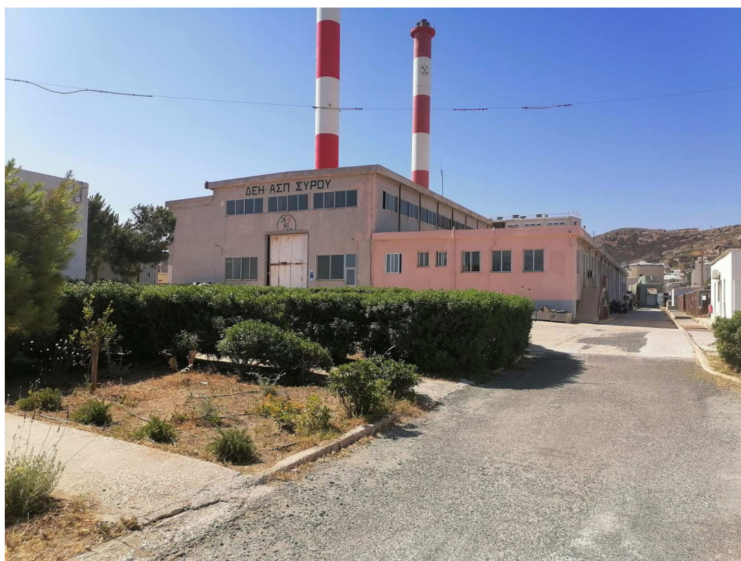
Εικόνα 4 Ευρύτερη άποψη του συνόλου των κτισμάτων του Μηχανοστασίου Α.
