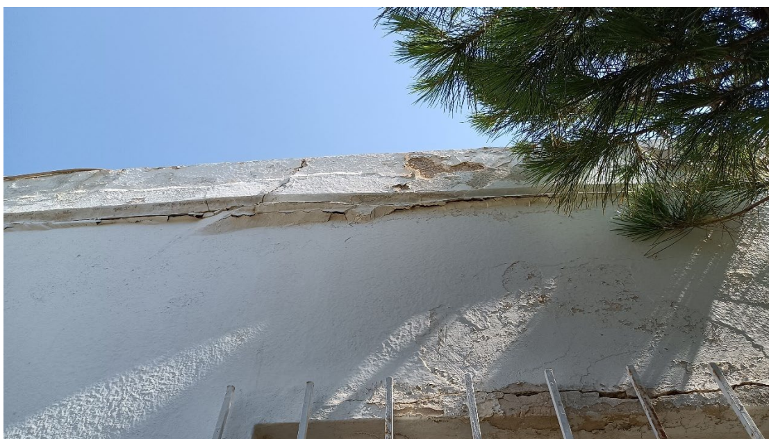
Εικόνα 29 Αποψη από εξωτερικά περιμετρικά στοιχεία όψης του κτιρίου γραφείων διοίκησης, κτίριο 5.
