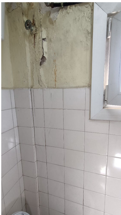
Εικόνα 38 Εσωτερική άποψη υφιστάμενου χώρου WC του κτιρίου γραφείων διοίκησης, κτίριο 5.
