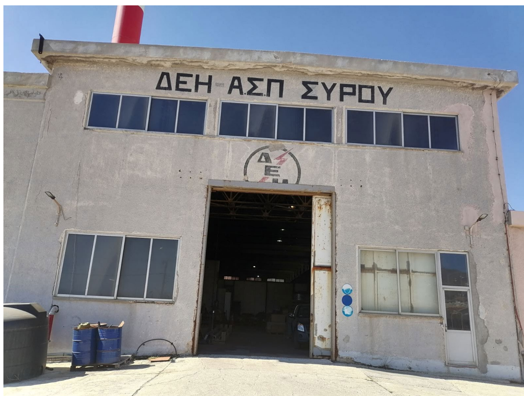
Εικόνα 3 Ενδεικτική απόψη της εισόδου του Μηχανοστασίου, κτίσμα Α.
