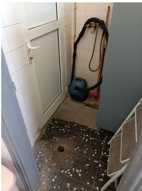
Εικόνα 39 Εσωτερική άποψη υφιστάμενου χώρου WC του κτιρίου γραφείων διοίκησης, κτίριο 5.
