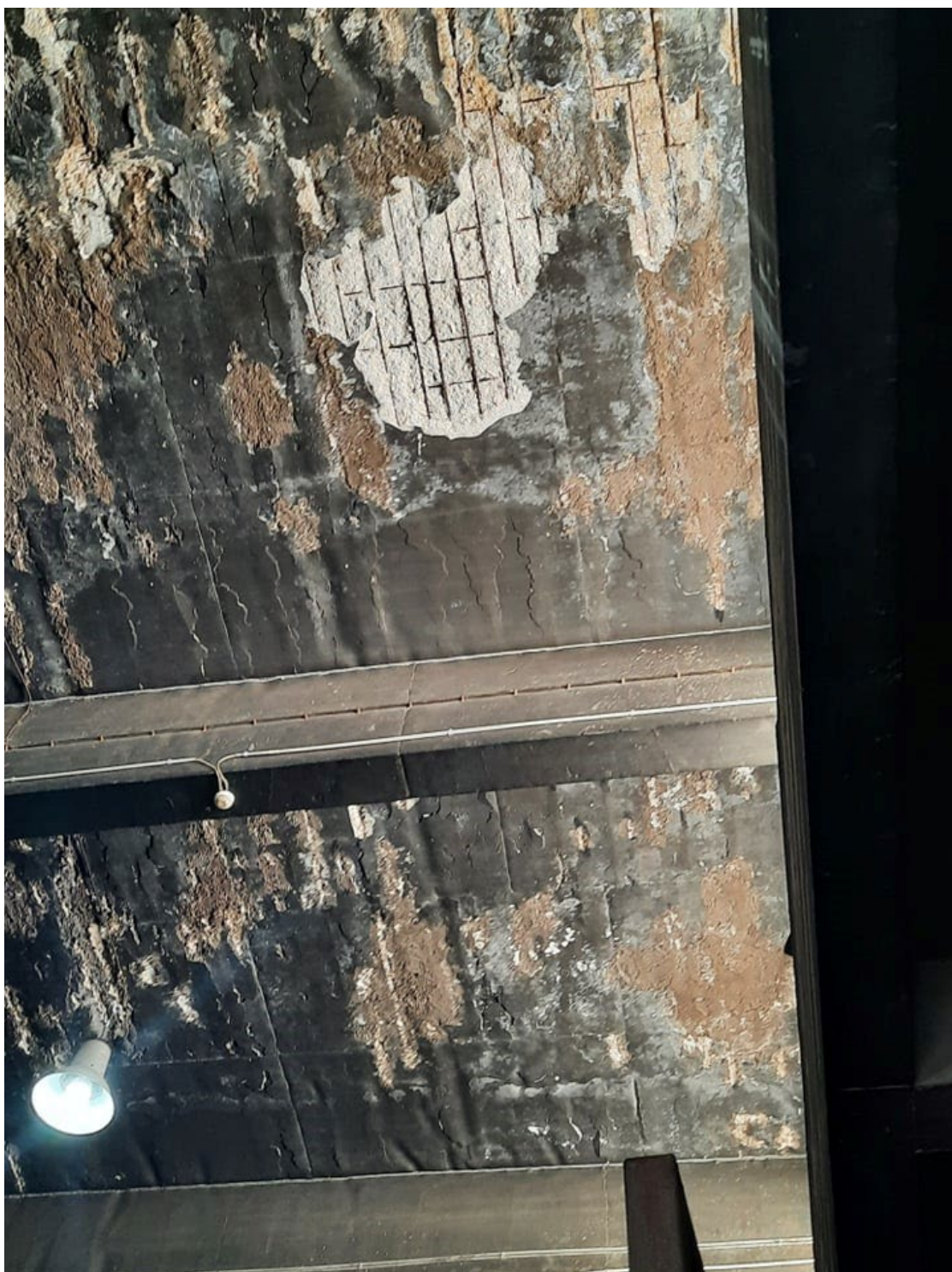
Εικόνα 9 Εσωτερική άποψη διαφόρων τμημάτων της κάτω παρειάς πλάκας οροφής ισογείου Μηχανοστασίου, κτίσμα Α.
