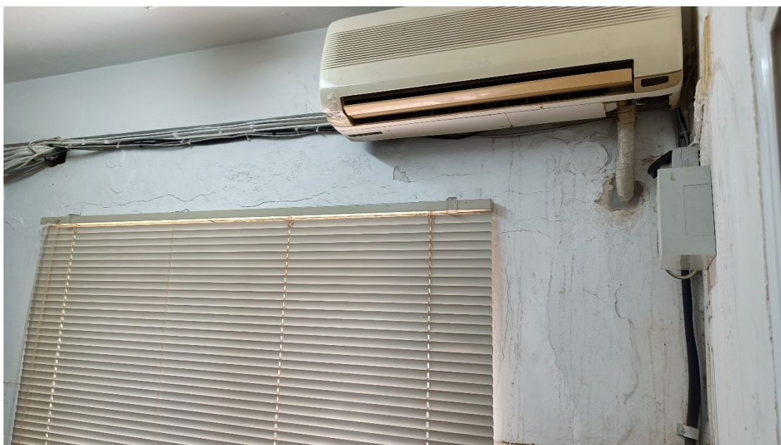
Εικόνα 32 Εσωτερική άποψη χώρων του κτιρίου γραφείων διοίκησης, κτίριο 5.
