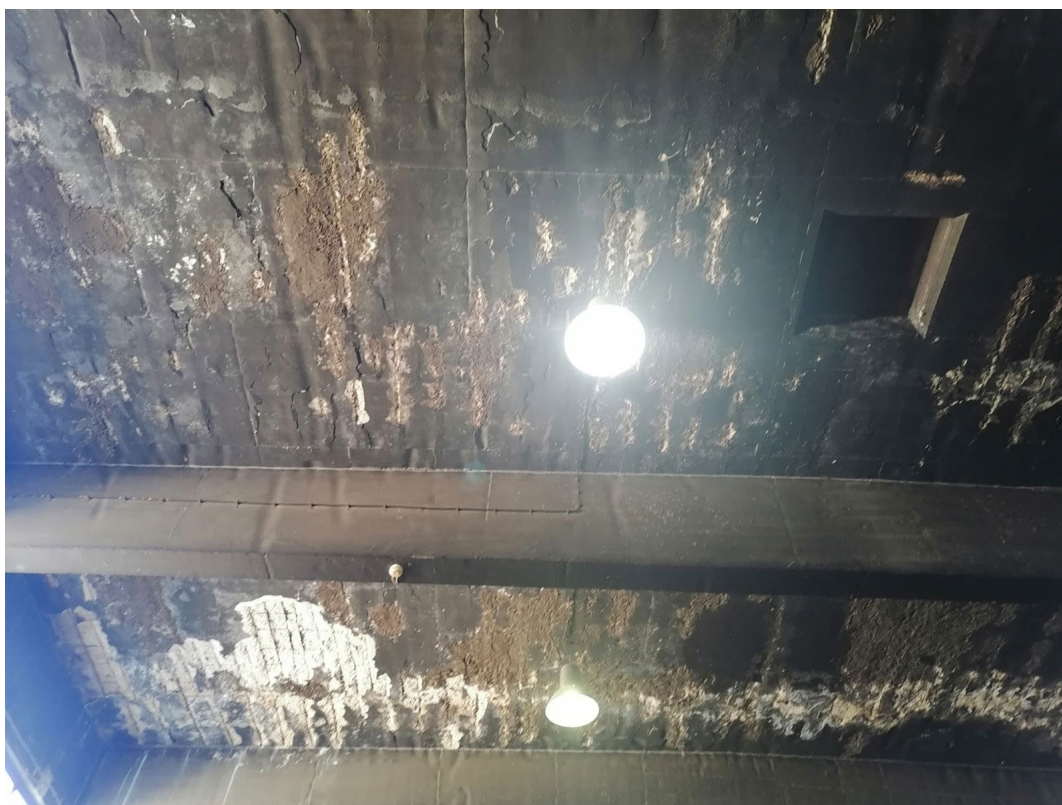
Εικόνα 6 Εσωτερική άποψη διαφόρων τμημάτων της κάτω παρειάς πλάκας οροφής ισογείου Μηχανοστασίου, κτίσμα Α.
