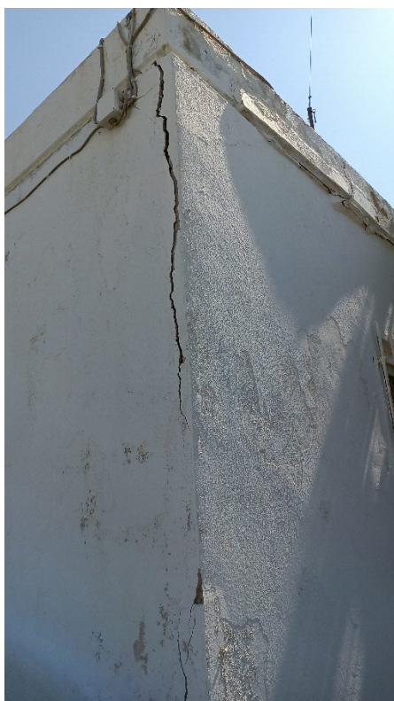
Εικόνα 26 Αποψη από εξωτερικά περιμετρικά στοιχεία όψης του κτιρίου γραφείων διοίκησης, κτίριο 5.
