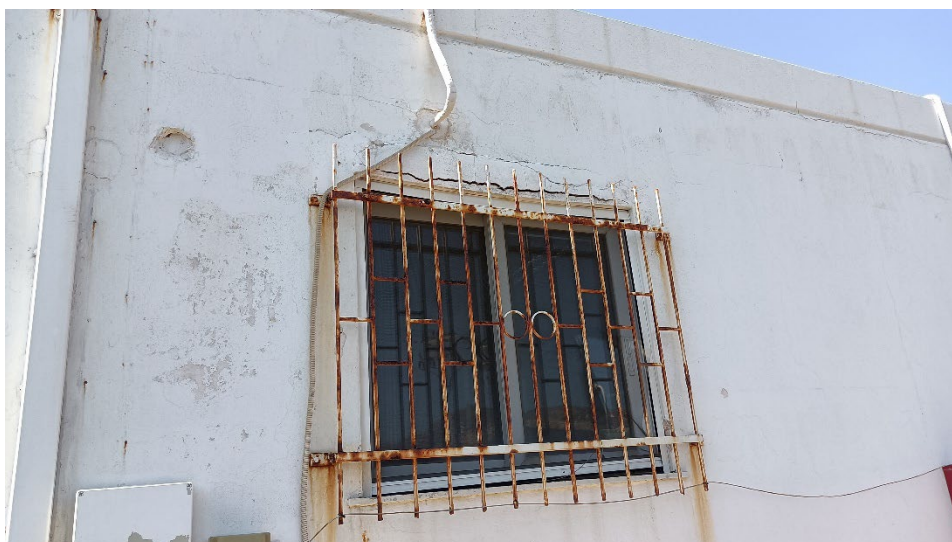
Εικόνα 21 Άποψη από εξωτερικά περιμετρικά στοιχεία όψης του κτιρίου γραφείων διοίκησης, κτίριο 5.
