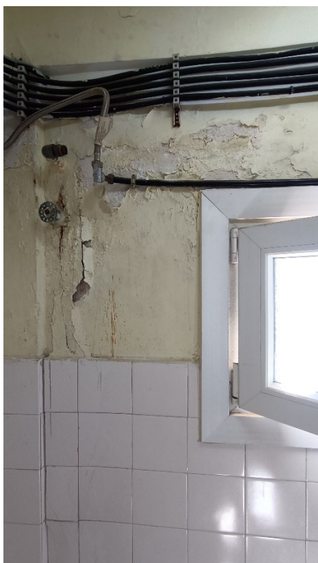
Εικόνα 37 Εσωτερική άποψη υφιστάμενου χώρου WC του κτιρίου γραφείων διοίκησης, κτίριο 5.
