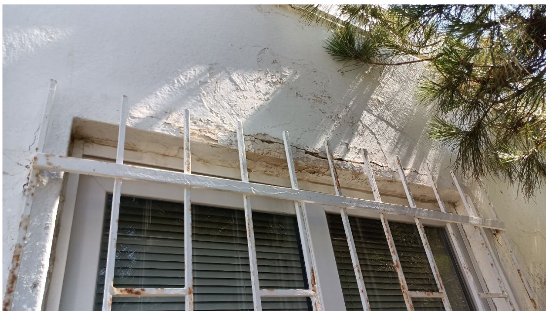
Εικόνα 28 Αποψη από εξωτερικά περιμετρικά στοιχεία όψης του κτιρίου γραφείων διοίκησης, κτίριο 5.
