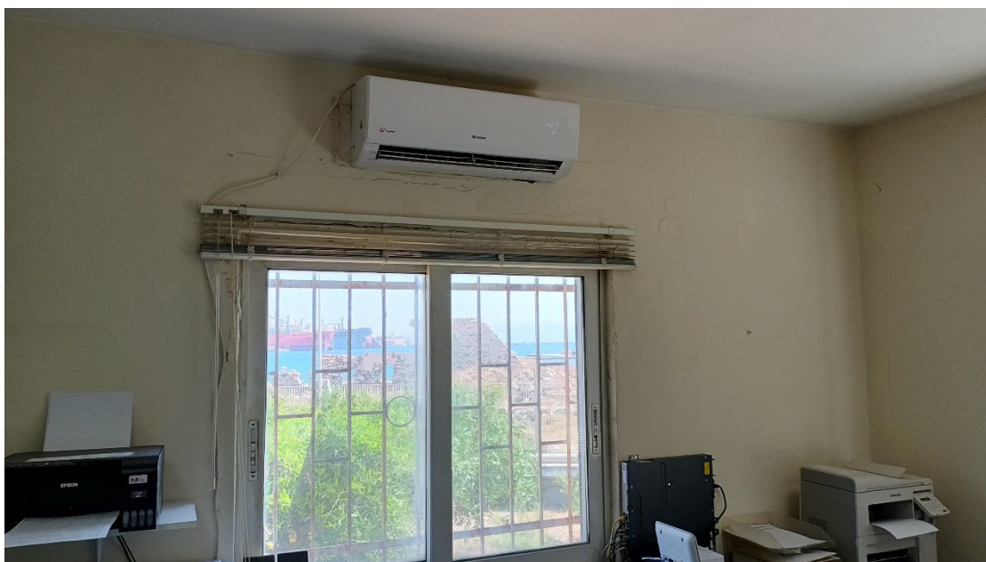
Εικόνα 34 Εσωτερική άποψη χώρων του κτιρίου γραφείων διοίκησης, κτίριο 5.
