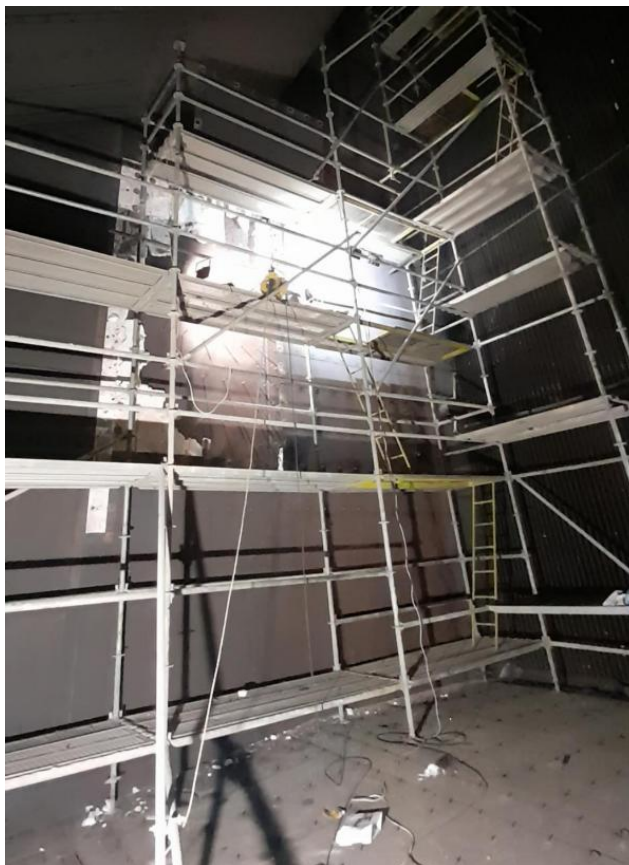
Εικόνα από παλαιότερη επισκευή
