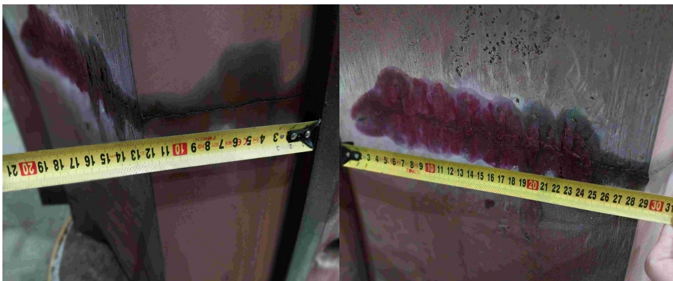
Αριστερή πλευρά εσωτερική
