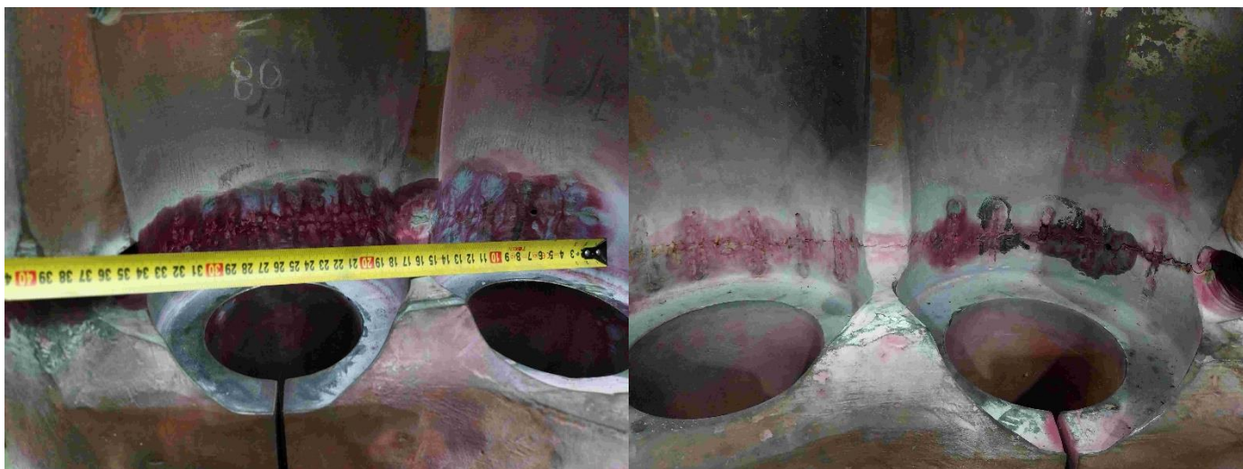
Αριστερή πλευρά εξωτερική
