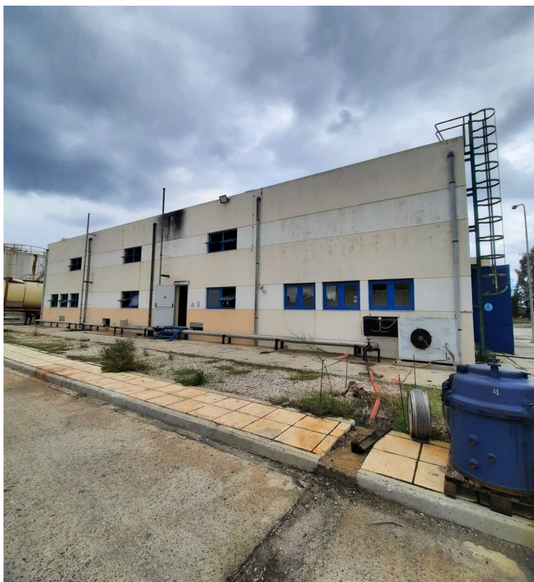
Εικ. 5 Κτίριο Pielstick
