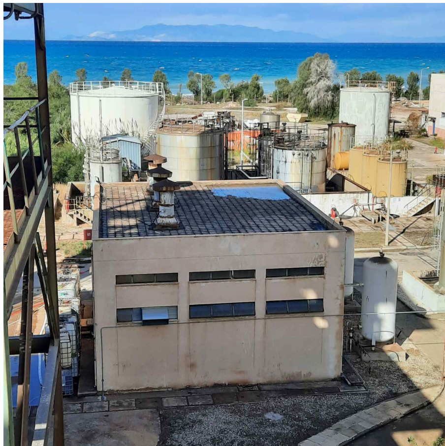
Εικ. 1 Κτίριο Αποσυμπιεστών
