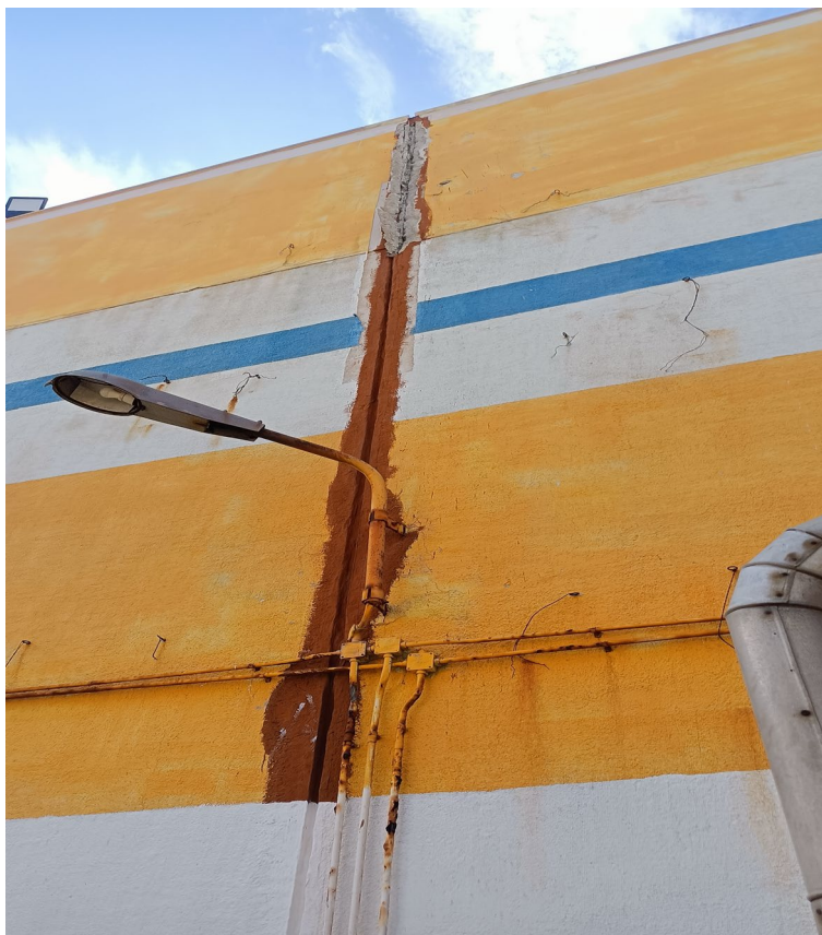
Εικ. 4 Αρμός διαστολής κτιρίου ΑΗΜ
