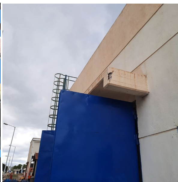
Εικ. 8 Κτίριο Pielstick
