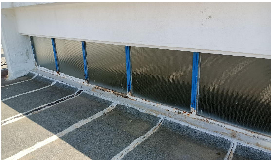
Εικ. 3 Υαλοστάσια κτιρίου ΑΗΜ
