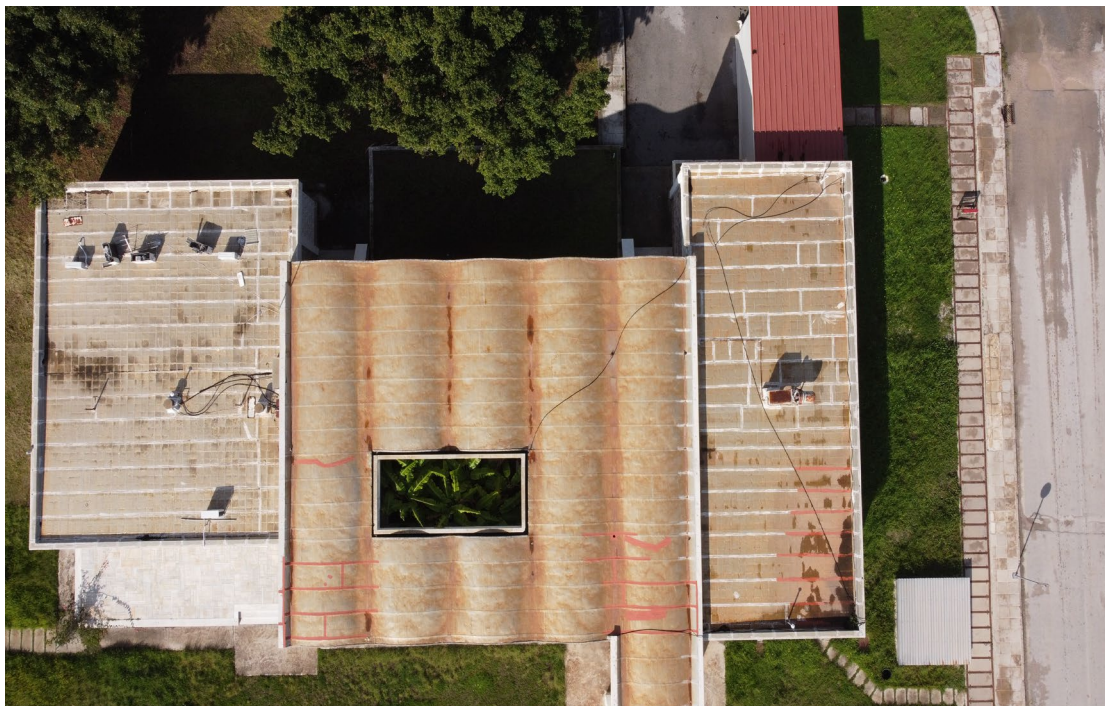
Εικ. 2 Κτίριο καντίνας-ξενώνα
