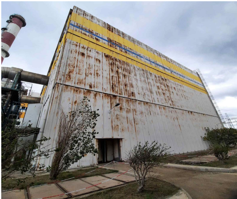
Εικ. 7 Κτίριο SULZER (μεταλλικό)
