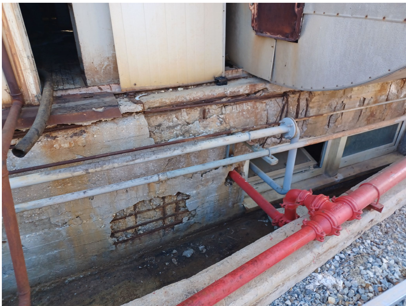
Εικόνα 1 Βάση οπλισμένου σκυροδέματος H/Z SULZER
