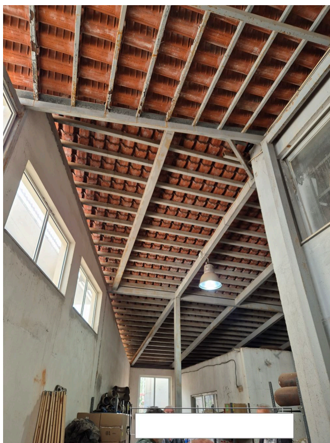
Εικόνα 4 Κτίριο επέκτασης με κεραμοσκεπή
