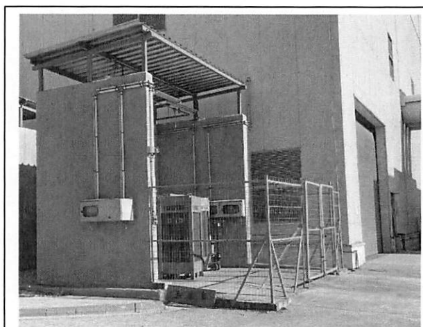
Φωτογραφία 2: Υφιστάμενη κατάσταση κτιρίου φιαλών κατανάλωσης H_2
