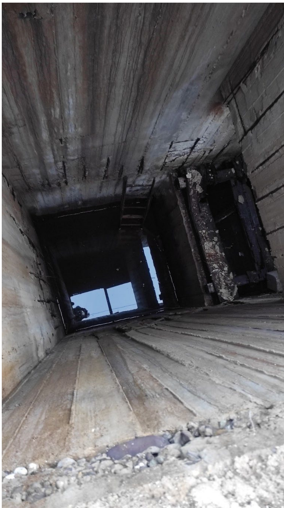
Φωτογραφία 13 Απόψεις τοιχίων φρεατίου άντλησης νερού πυρόσβεσης.
