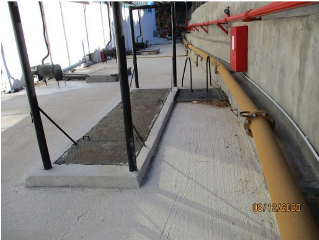
Φωτογραφία 6 Άποψη οροφής φρεατίων άντλησης νερού ψύξης.
