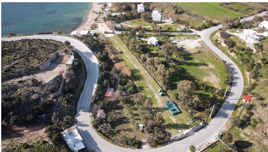
Φωτογραφία 10 Αεροφωτογραφία μέρους εγκατάστασης ΤΣΠ Σκύρου, τμήμα ΙΙ όπου διέρχονται οι αγωγοί προσαγωγής και απαγωγής θαλασσινού νερού ψύξης και πυρόσβεσης.
