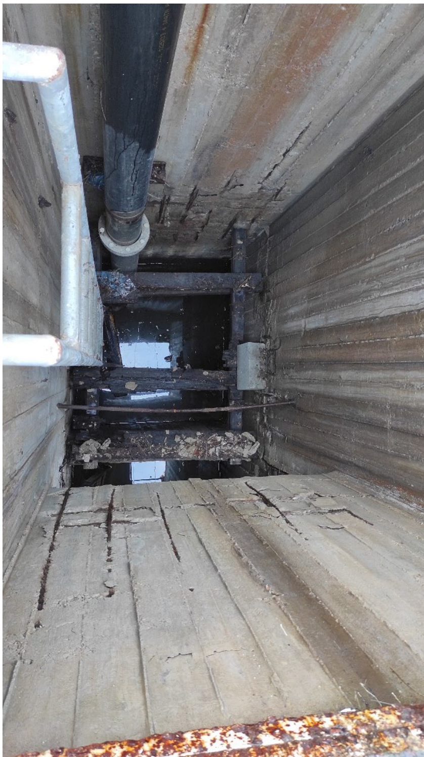
Φωτογραφία 11 Απόψεις τοιχίων φρεατίου άντλησης νερού πυρόσβεσης.
