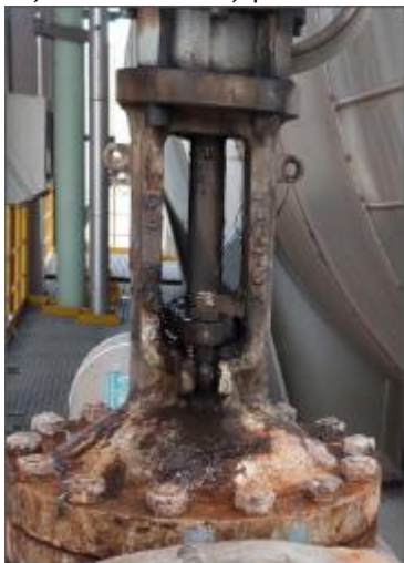
Εικόνα 1&2: Διαβρώσεις σε βάνες που πρέπει να καθαριστούν
