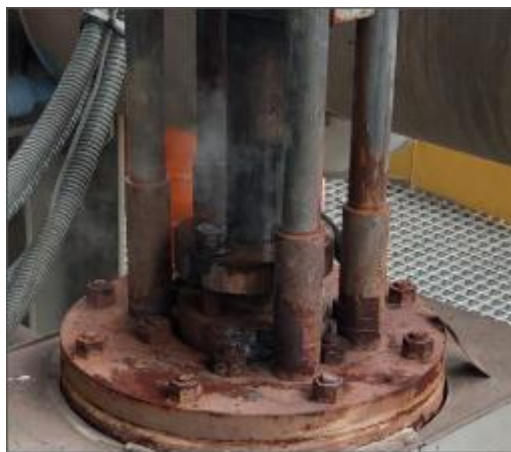
Εικόνα 1&2: Διαβρώσεις σε βάνες που πρέπει να καθαριστούν
