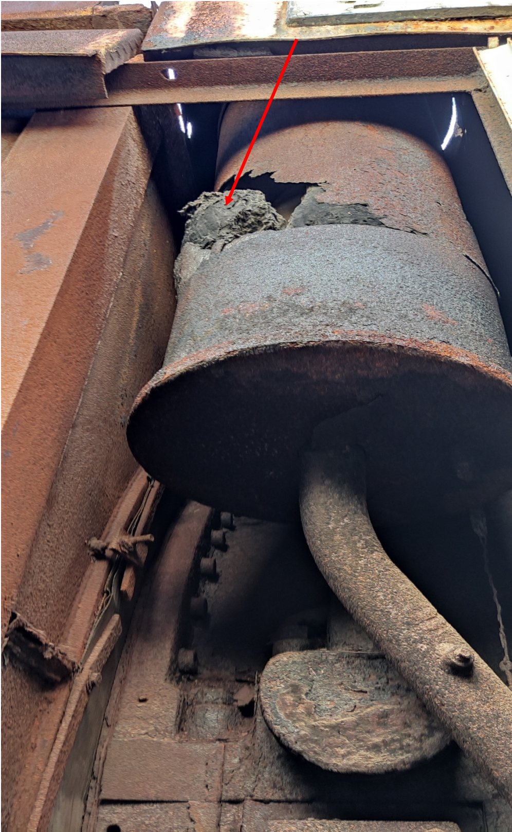
Εικόνα 8: Μόνωση SMF στο φίλτρο
