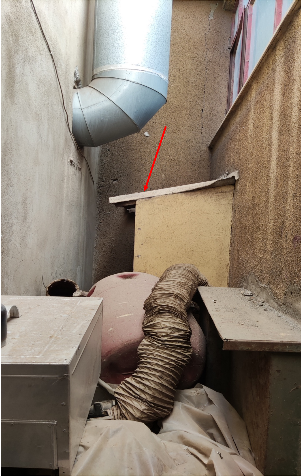
Εικόνα 4: Μικρό Στέγαστρο στον διάδρομο του Μηχανουργείου
