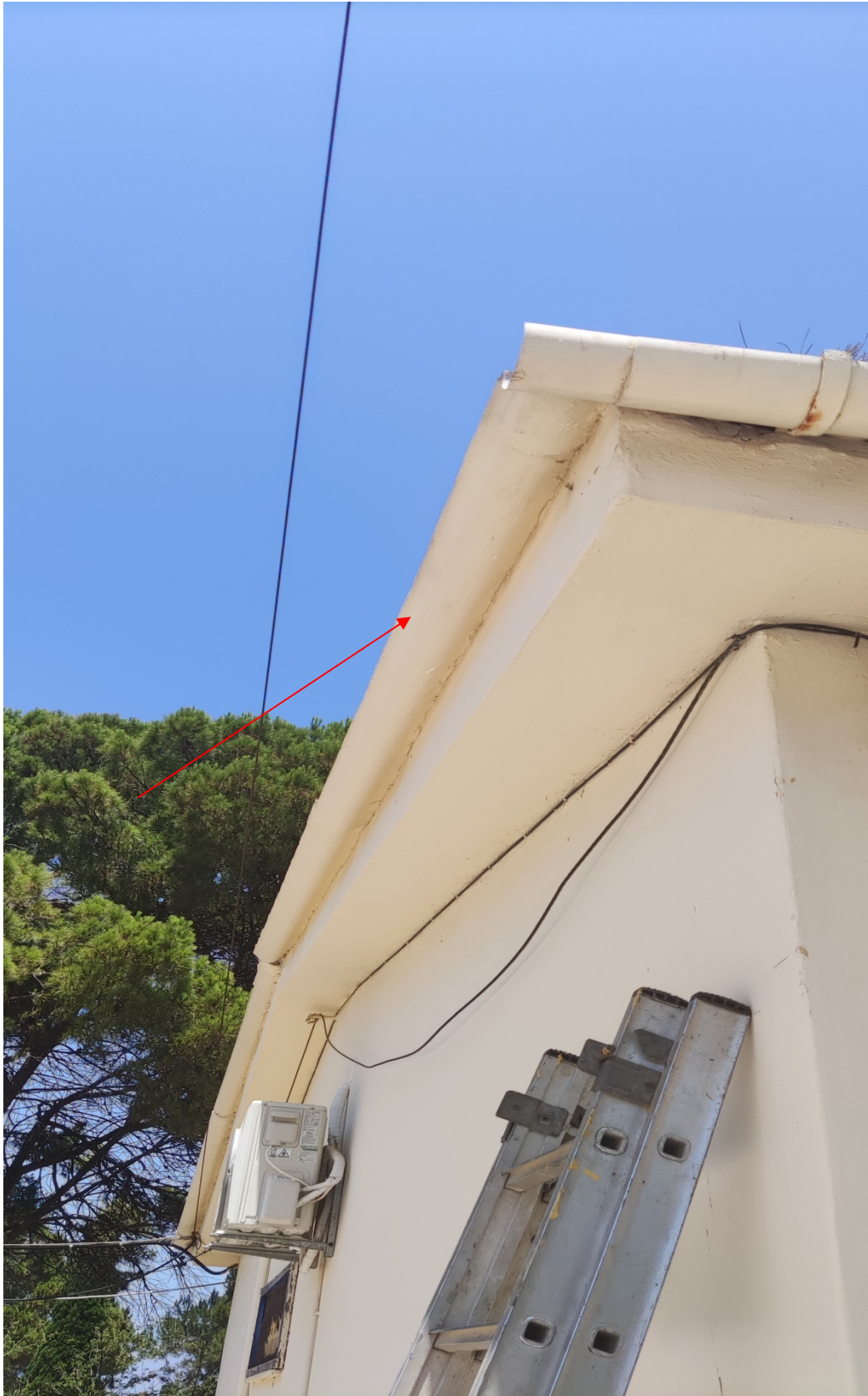
Εικόνα 11: Δείγμα στέγης ΚΜΕΕΕ
