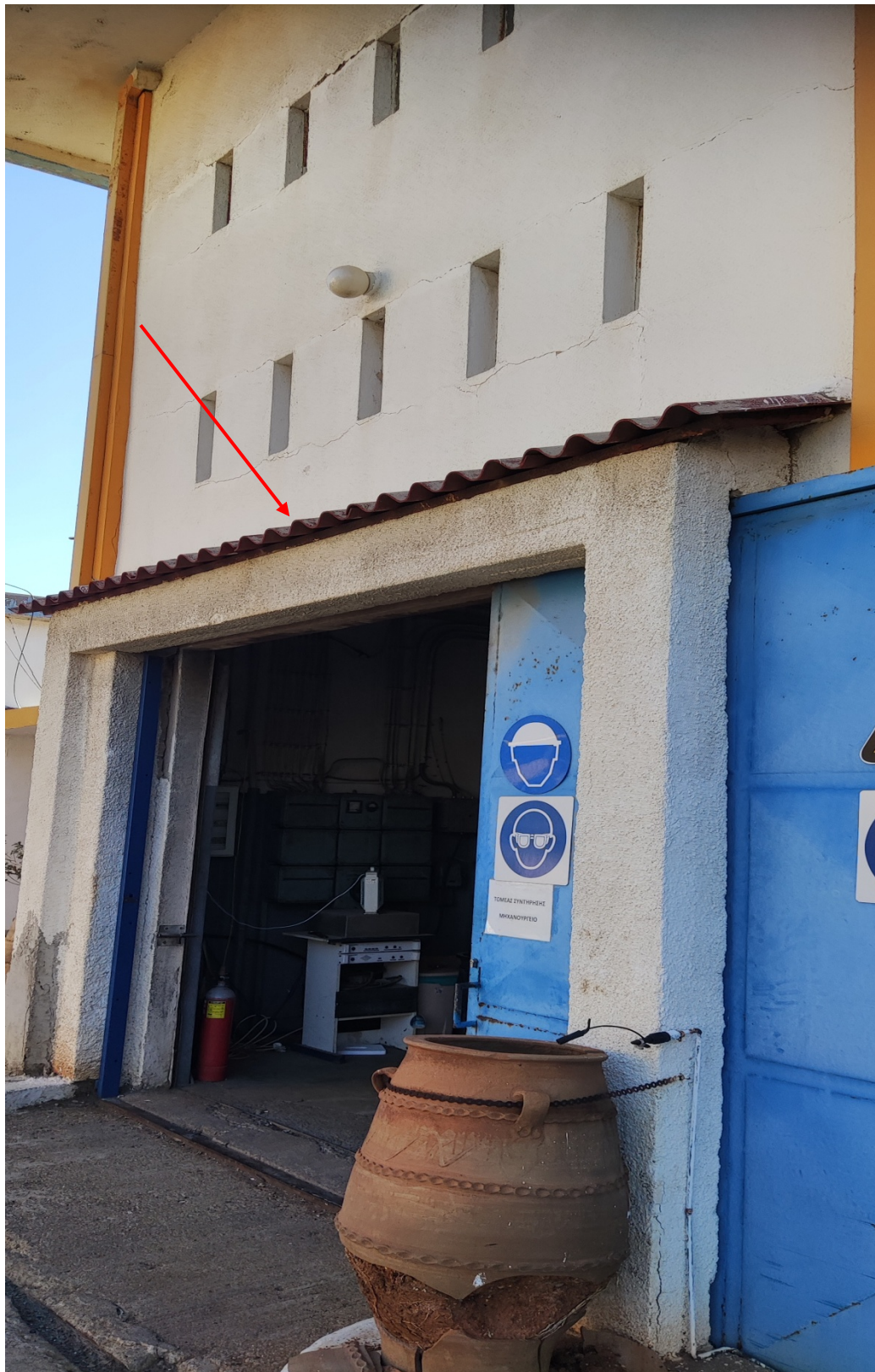
Εικόνα 3: Μικρό Στέγαστρο στην είσοδο του Μηχανουργείου
