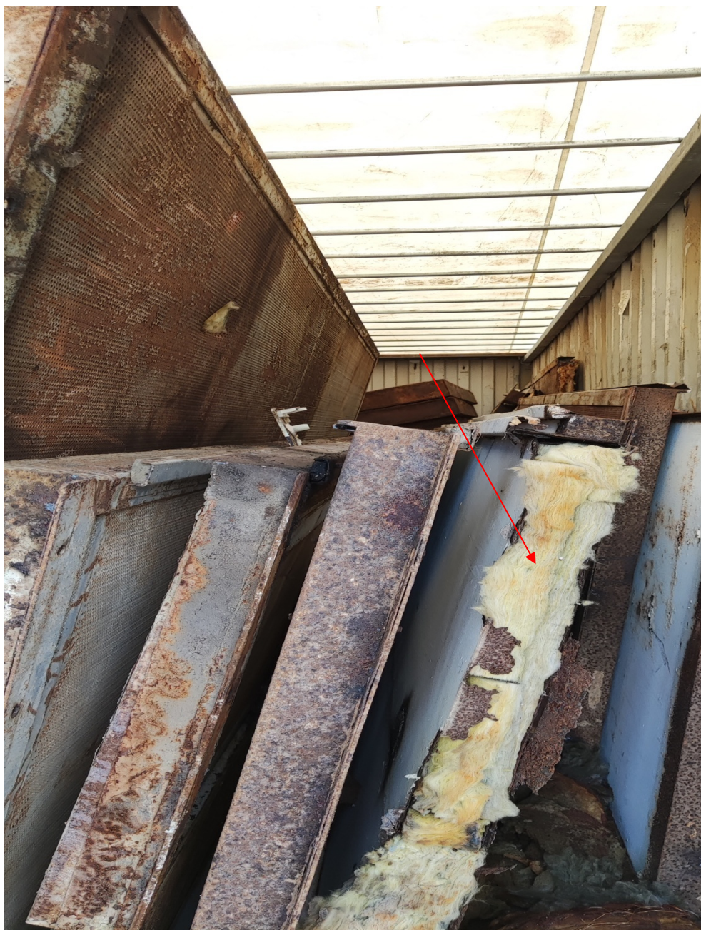
Εικόνα 5: Μόνωση SMF στο δεξιό container
