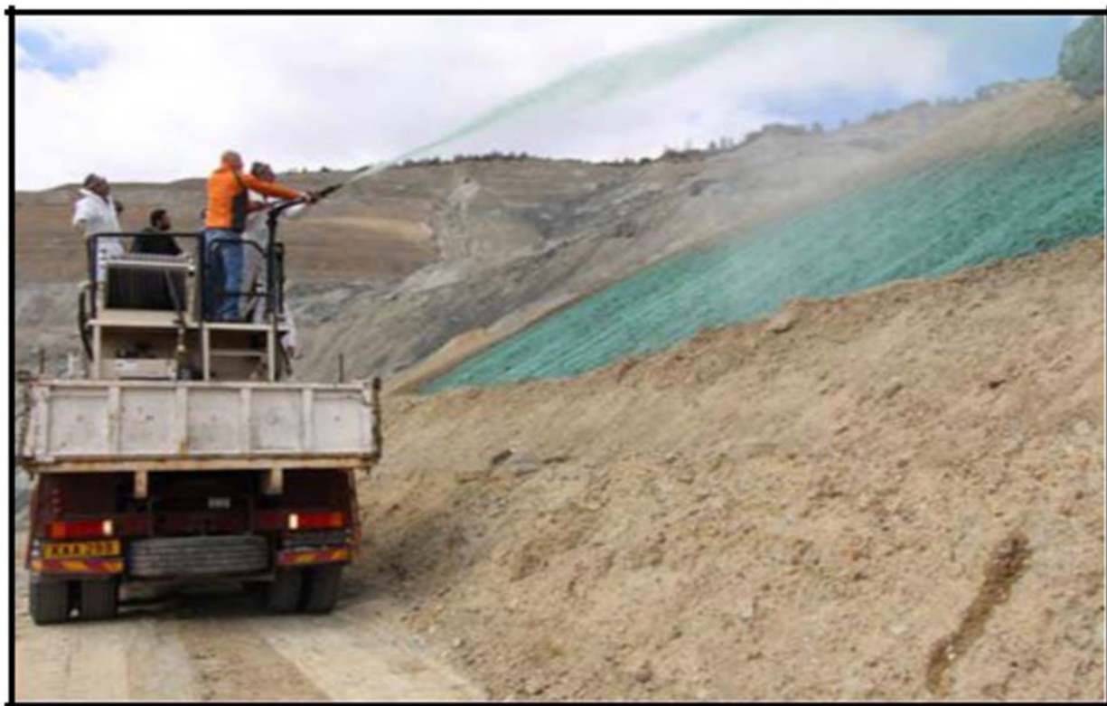
Φωτογραφία 10.3.2.3.2.3 : «Εφαρμογή υδροσποράς με ειδικό αυτοκινούμενο όχημα»
