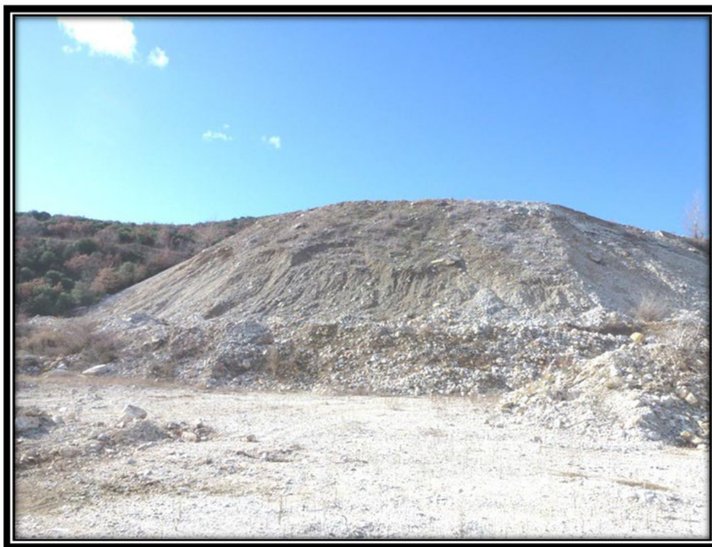
Φωτογραφία 7.2.2.4: «Άποψη της 1ης βαθμίδας και του Πρανές 2»
