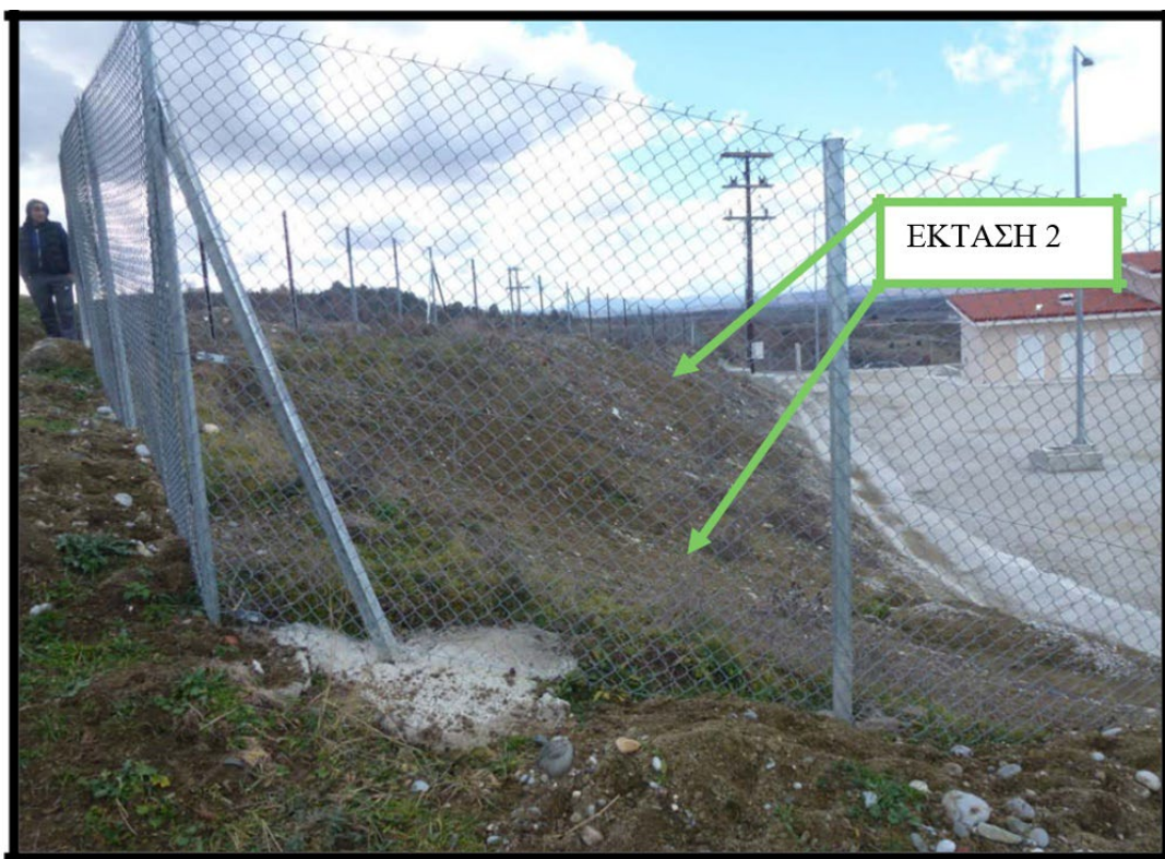
Φωτογραφία 11.2.2.2: «Νοτιοδυτική άποψη της έκτασης 2»
