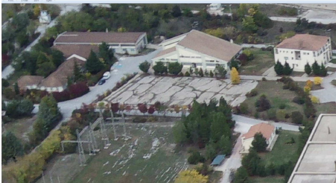
Εικόνα 5-94: Αποψη συγκροτήματος κτηρίων ΣΤΕ Καρδιάς
