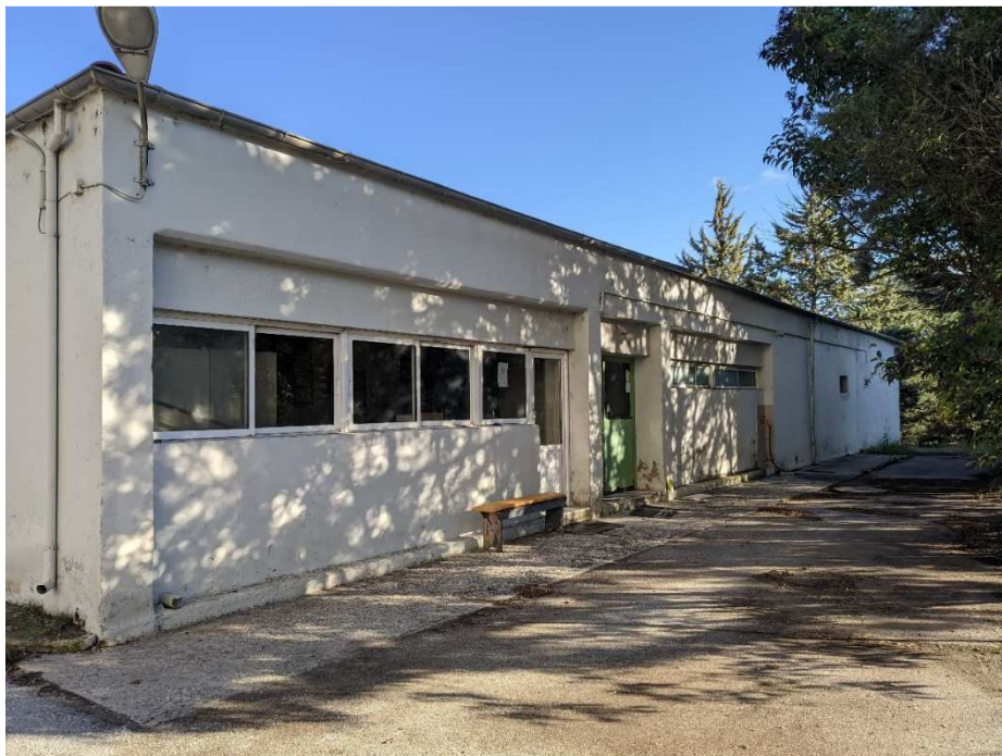
Εικόνα 5-84: Εξωτερική άποψη κτηρίου αποδυτηρίων προσωπικού
