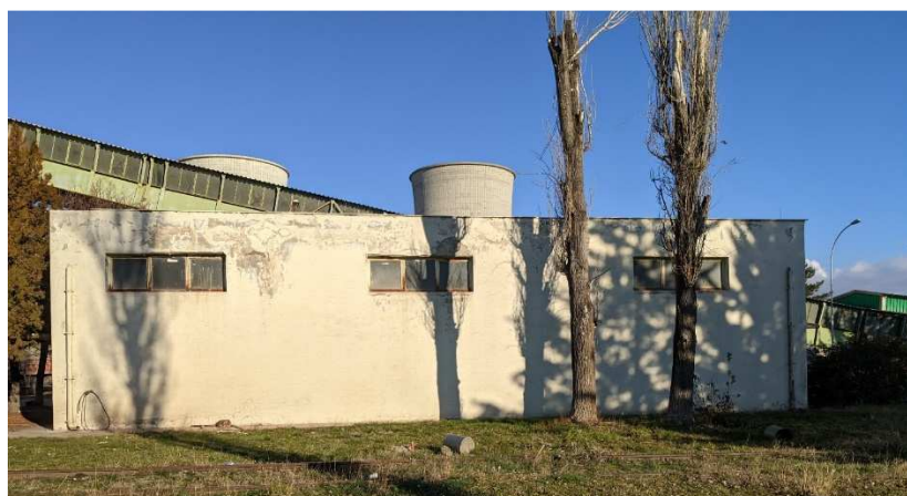
Εικόνα 5-92: Εξωτερική άποψη κτηρίου Ξυλουργείου
