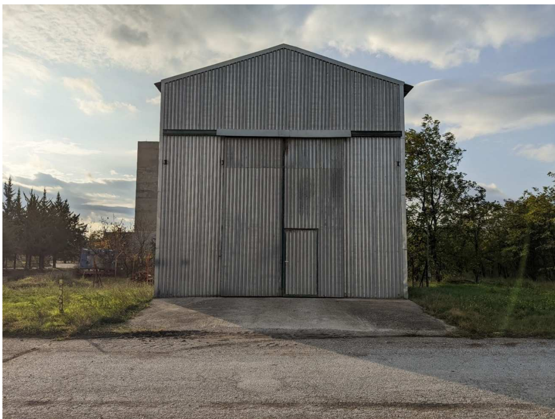
Εικόνα 5-81: Άποψη Κτήριου αμμοβολής
