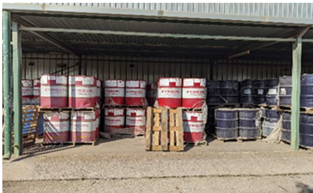
Εικόνα 5-115: Μεταλλικό Υπόστεγο λιπαντικών Υ3,1-02B
