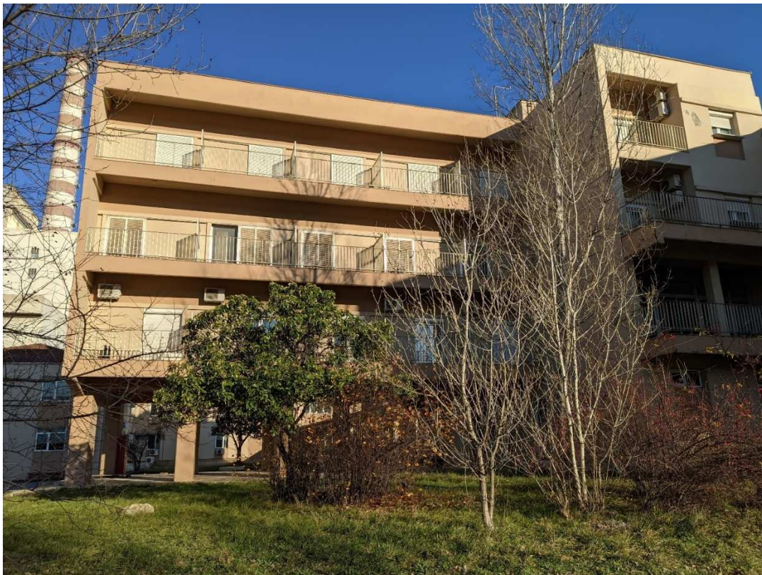
Εικόνα 5-55: Άποψη κτηρίου Ξενώνα
