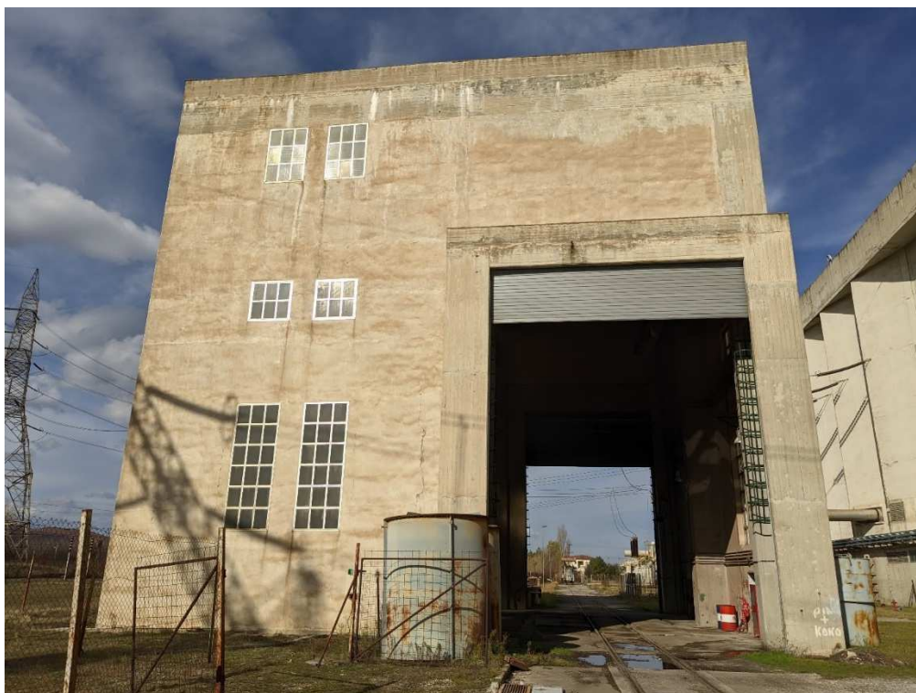
Εικόνα 5-78: Εξωτερική άποψη κτηρίου επισκευής μετασχηματιστών
