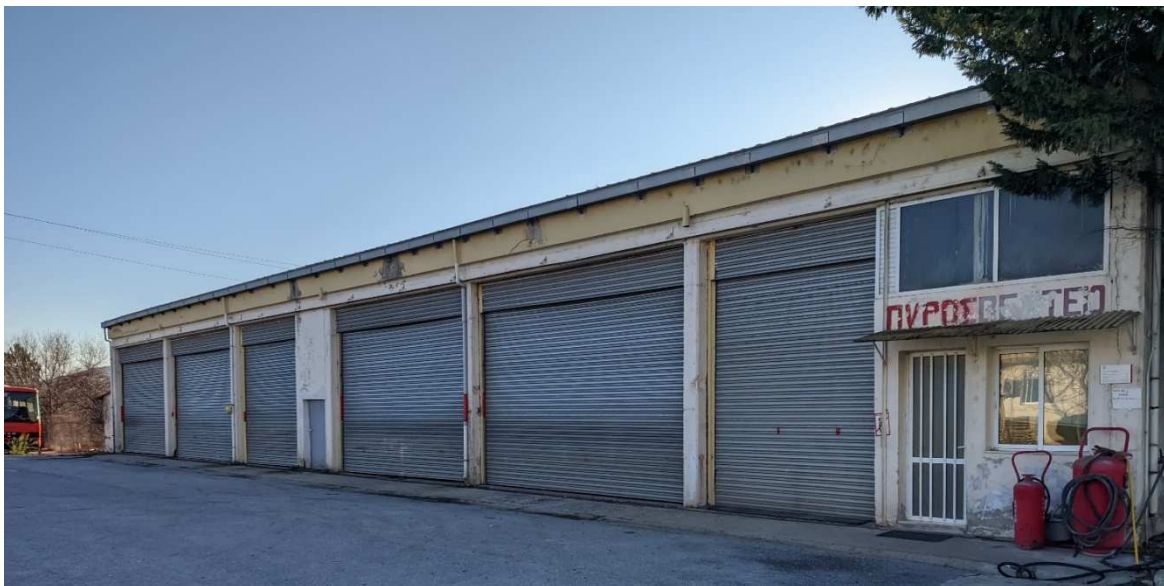
Εικόνα 5-69: Όψη γκαράζ μεγάλων οχημάτων και εργαστήριο αναγώμωσης πυροσβεστήρων
