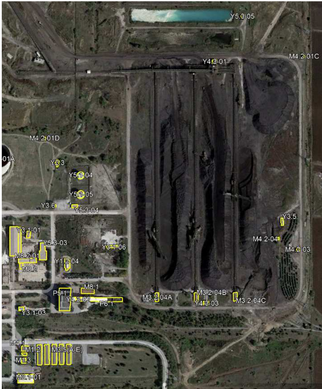
Εικόνα 4-3: Αυλή λιγνίτη, χώρος ΣΚΥΒΑ, δεξαμενές καυσίμων, κτίριο σπαστήρων λιγνίτη, αποθήκες και κτίρια/εγκαταστάσεις εισόδου του σταθμού Καρδιάς
