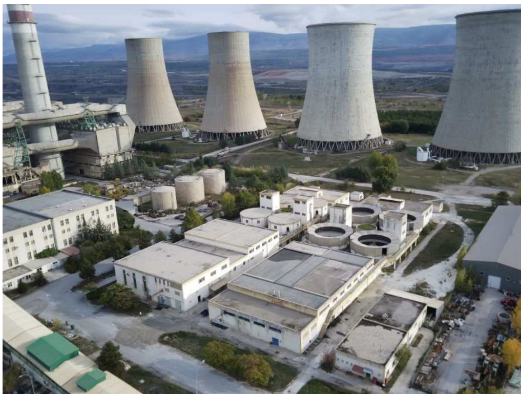
Εικόνα 5-43: Μονάδα επεξεργασίας νερού
