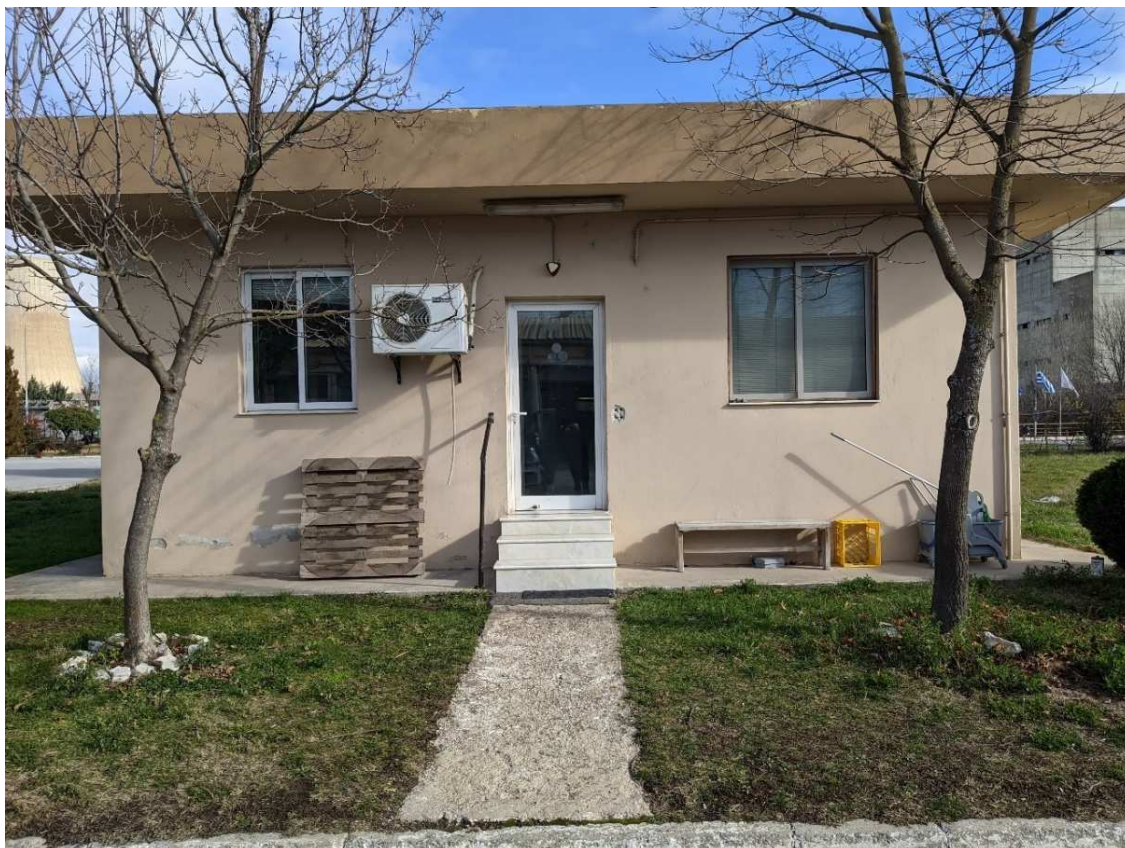
Εικόνα 5-66: Όψη κτηρίου Γραφείο κινήσεως M1.3
