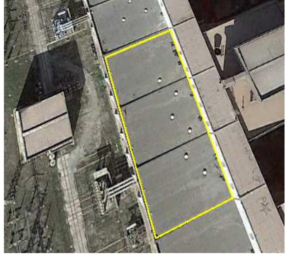
Μηχανοστάσιο Μον II P1.1-02
