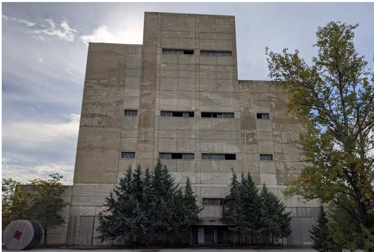
Εικόνα 5-41: Όψη κτηρίου σπαστήρα
