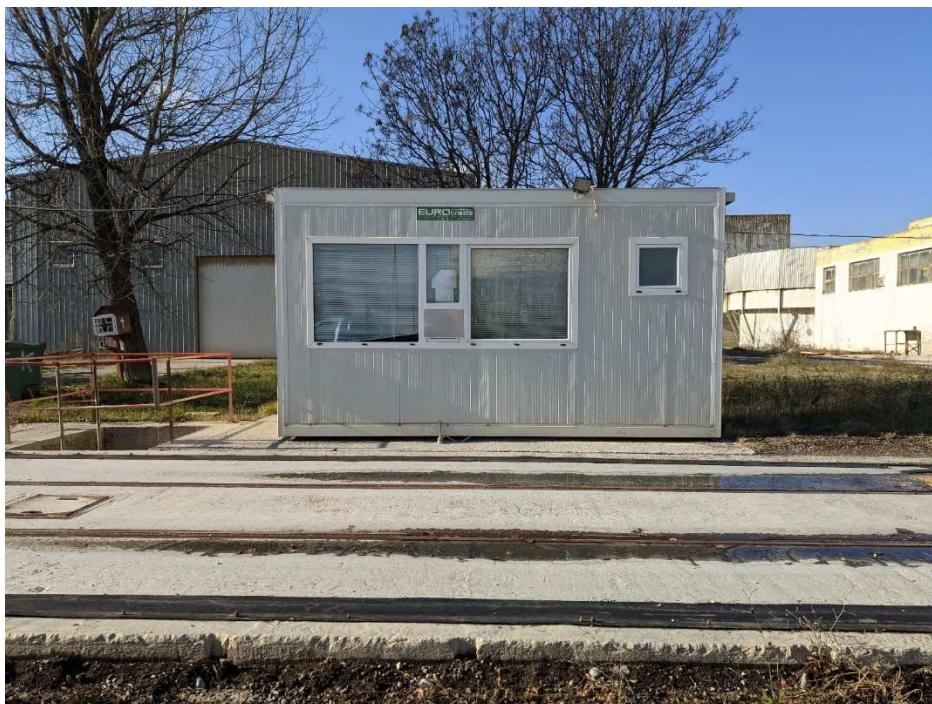
Εικόνα 5-101: Άποψη κτηρίου Σταθμού ζυγίσσεως
