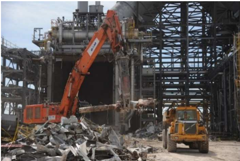
Εικόνα 7-1 Αποξήλωση σταθμού ηλεκτροπαραγωγής στο Ηνωμένο Βασίλειο
