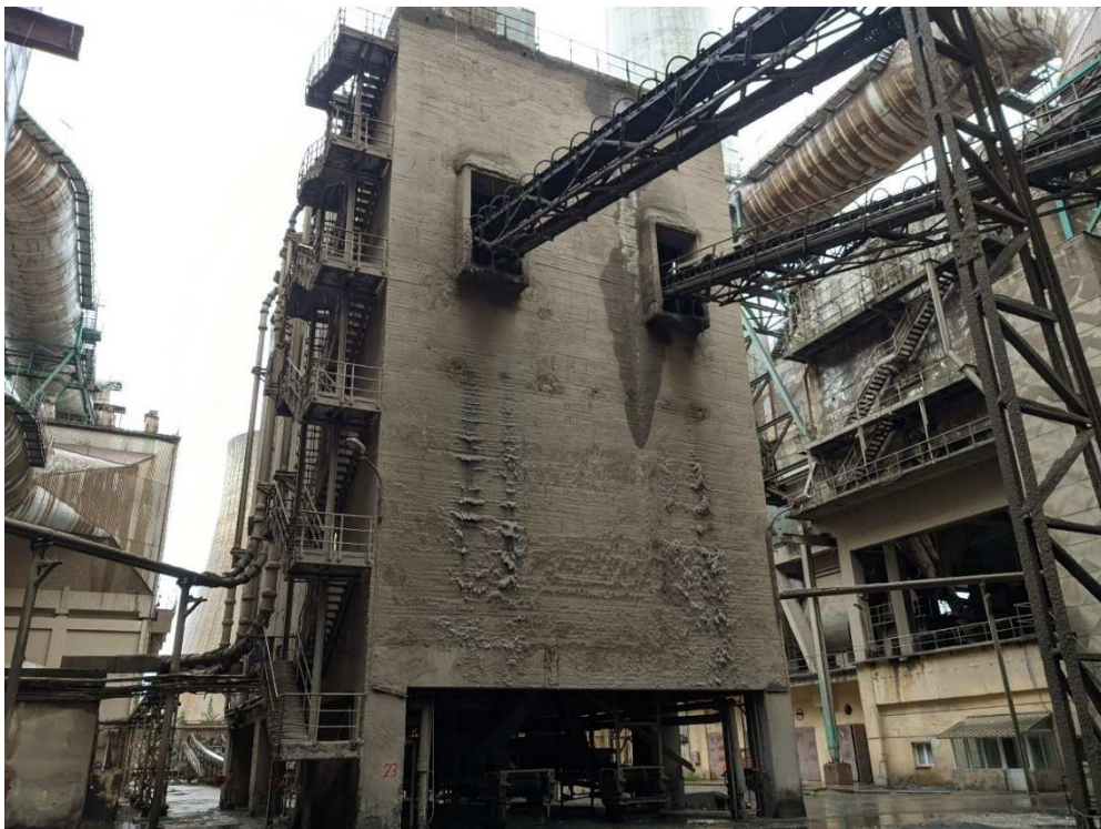
Εικόνα 5-35: Αποψη κτηρίου Σιλό τέφρας μονάδων I και II
