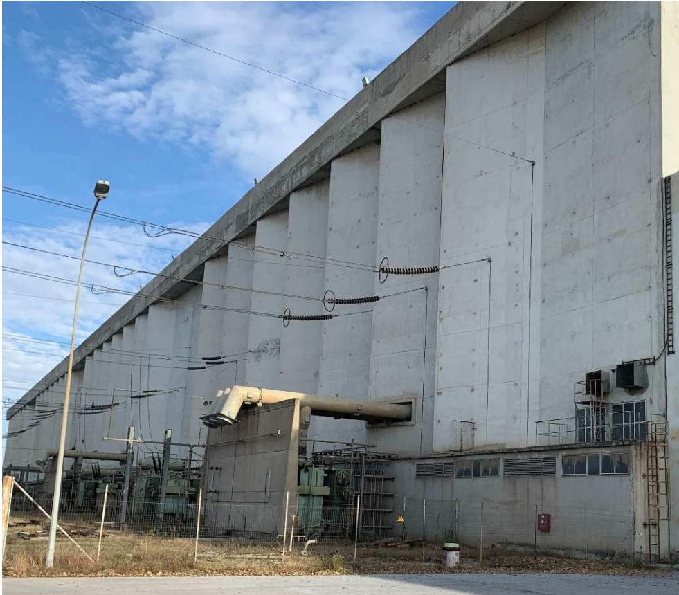
Εικόνα 5-10: Άποψη κτηρίων μηχανοστασίου
