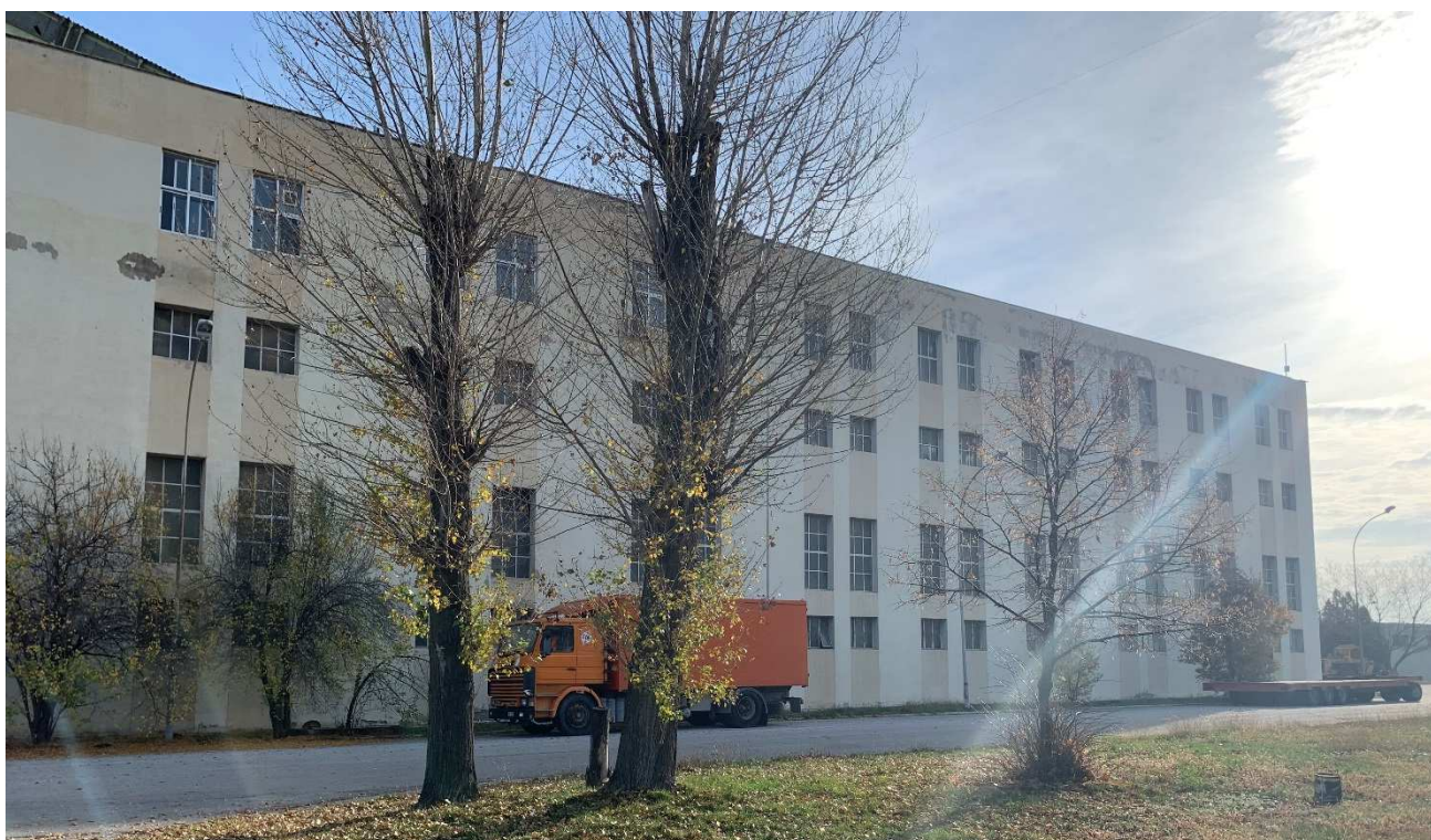
Εικόνα 5-119: Άποψη κτηρίου Μηχανουργείου
