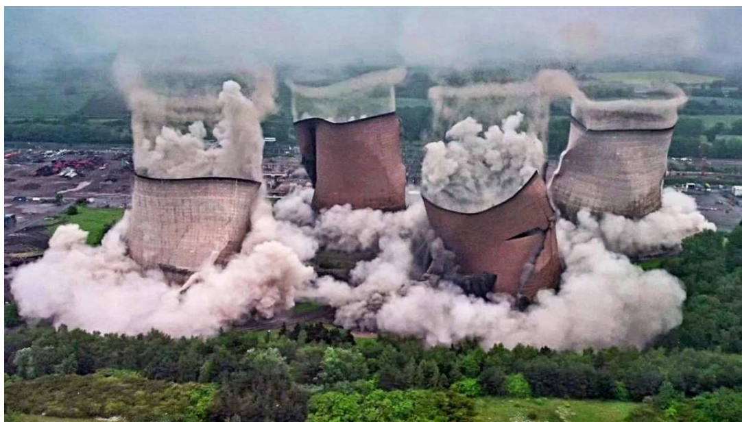
Εικόνα 7-2 Ελεγχόμενη έκρηξη σε 4 Πύργους Ψύξης στο Staffordshire, England
