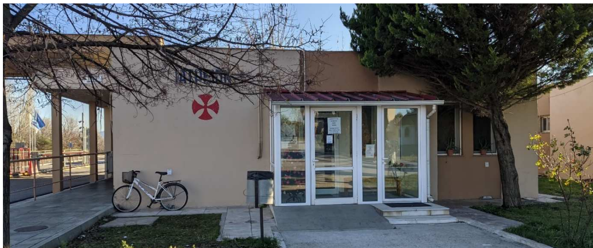
Εικόνα 5-61: Εξωτερική άποψη κτηρίου Κεντρικής πύλης και ιατρείου
