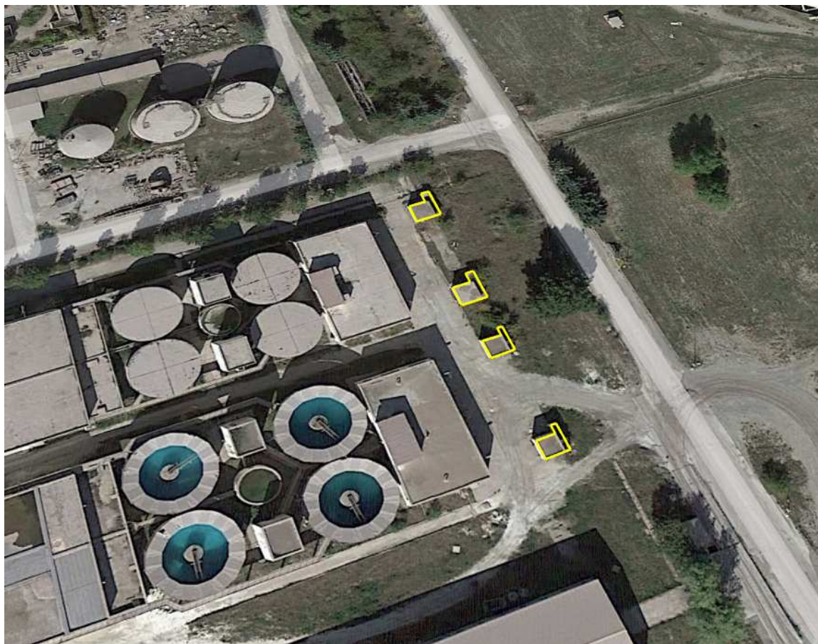
Εικόνα 5-45: Οικίσκοι πρόσβασης σε υπόγειες ταινίες μεταφοράς λάσπης του συγκροτήματος αποσκλήρυνσης (Υ2.3-01Α έως D από πάνω προς τα κάτω αντίστοιχα)
