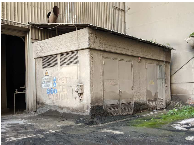
Εικόνα 5-88: Άποψη κτηρίων στέγασης μετασχηματιστών.
