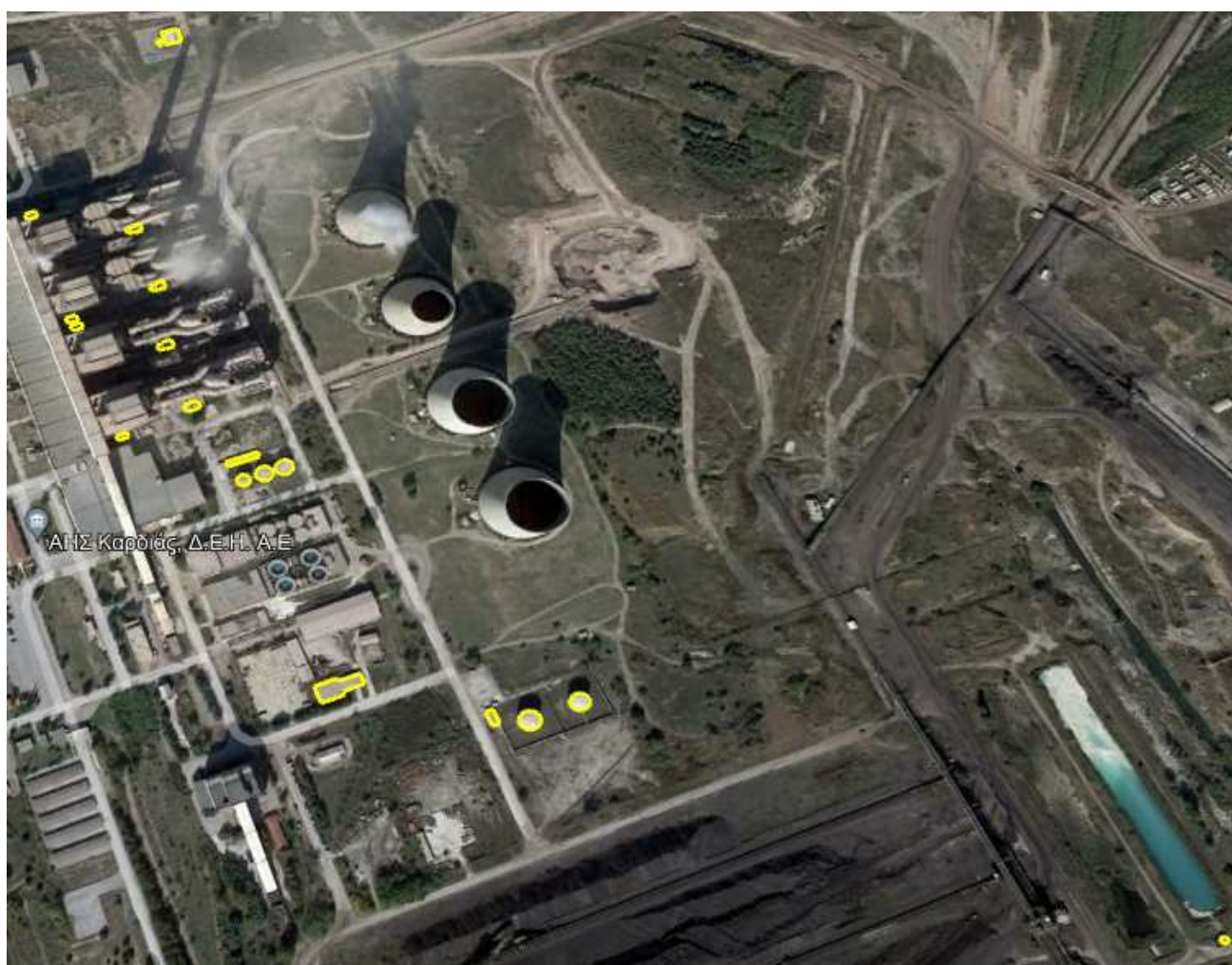
Εικόνα 5-126: Θέση εξωτερικών δεξαμενών και αντλιοστασίων ΑΗΣ Καρδιάς
