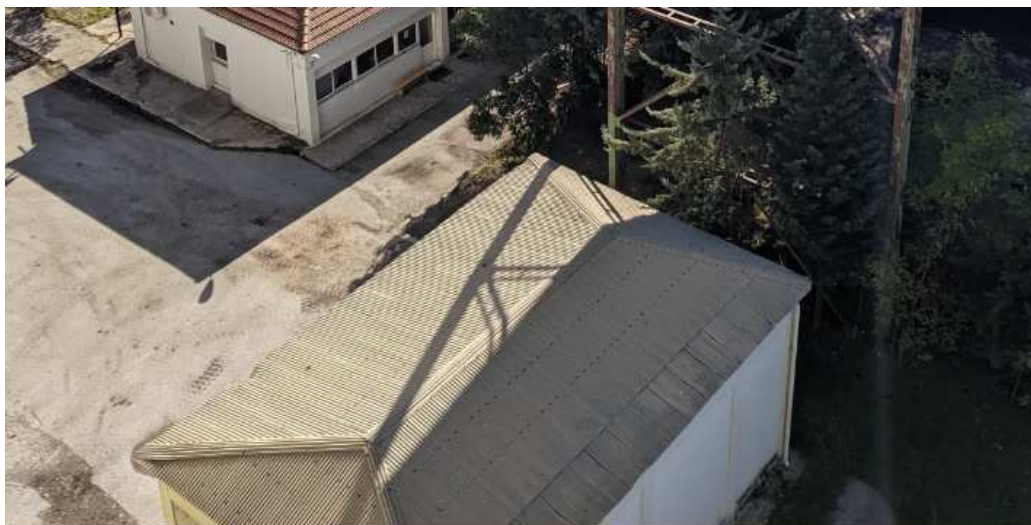
Εικόνα 5-76: Κτήριο υποσταθμού λιγνίτη Υ4,2-02
