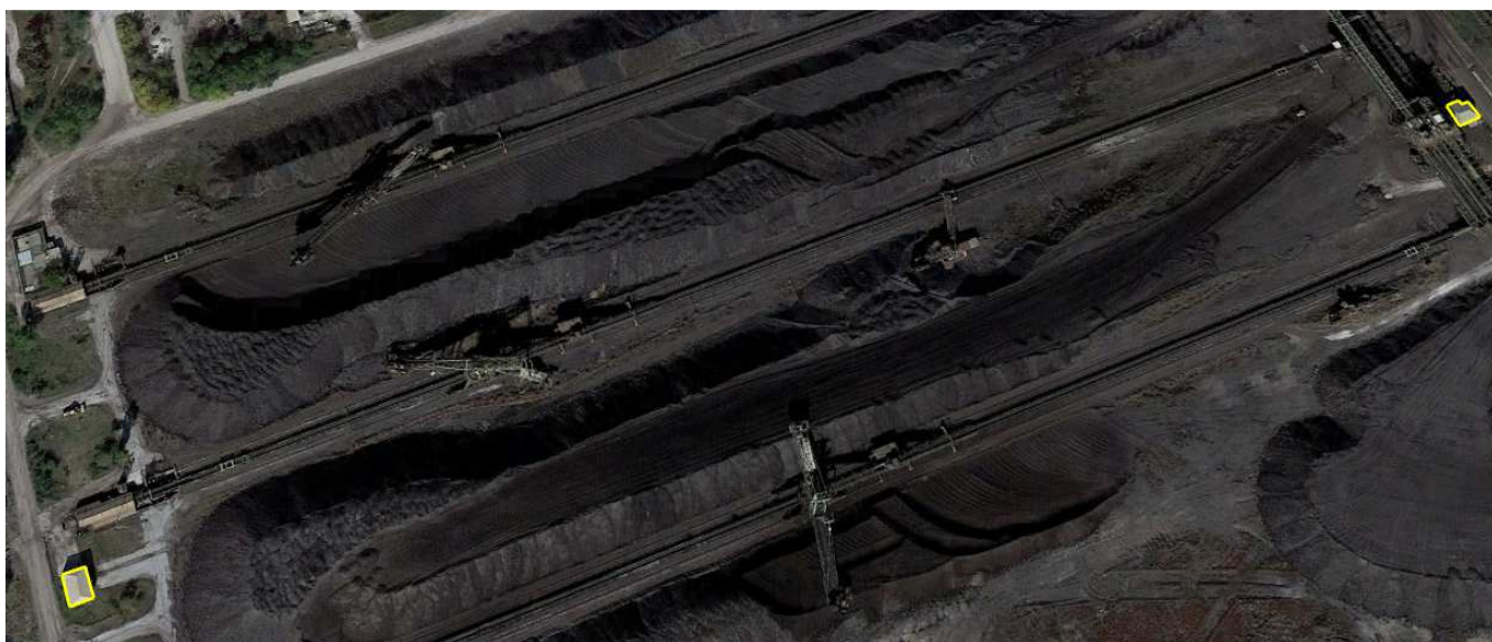
Εικόνα 5-75: Κτήρια υποσταθμών λιγνίτη Υ4,3-01, Υ4,3-02, Υ4,3-03.
