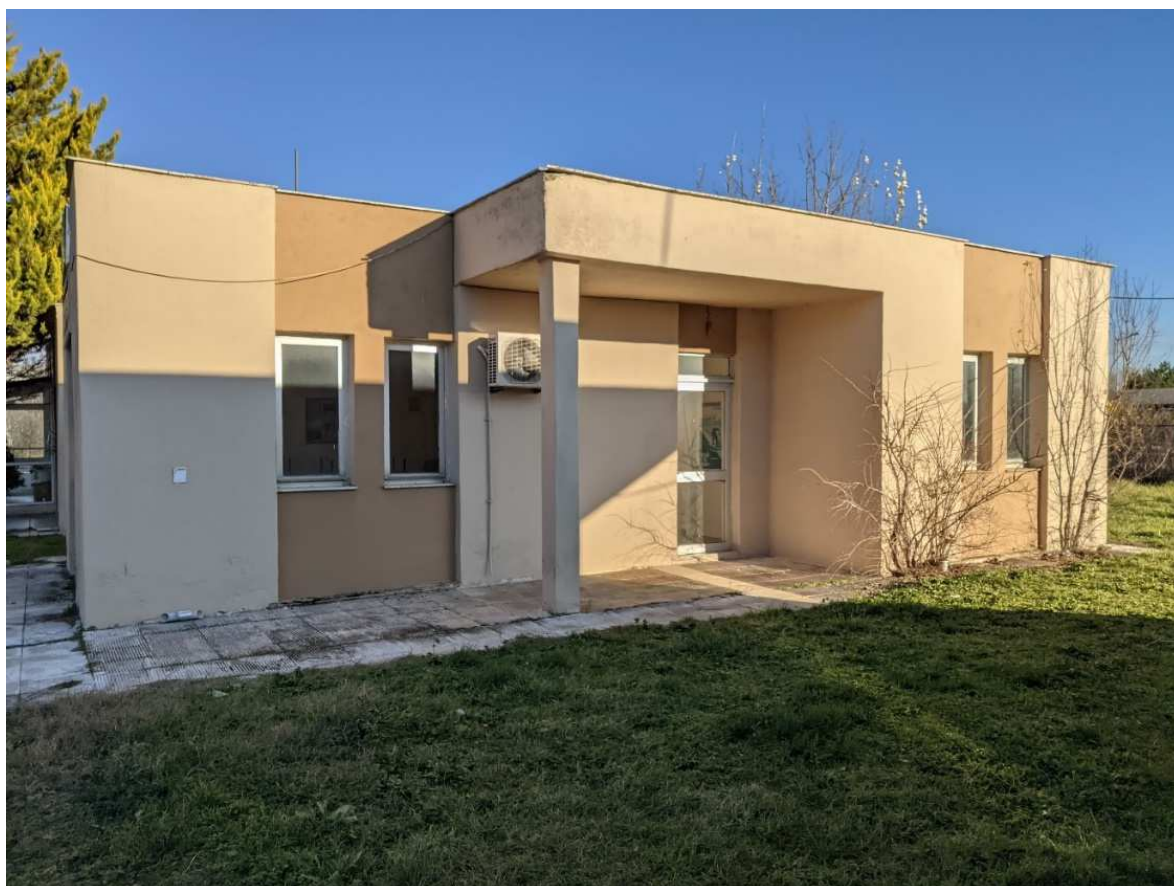
Εικόνα 5-63: Όψη κτήριου γραφείο σωματείων M1.2
