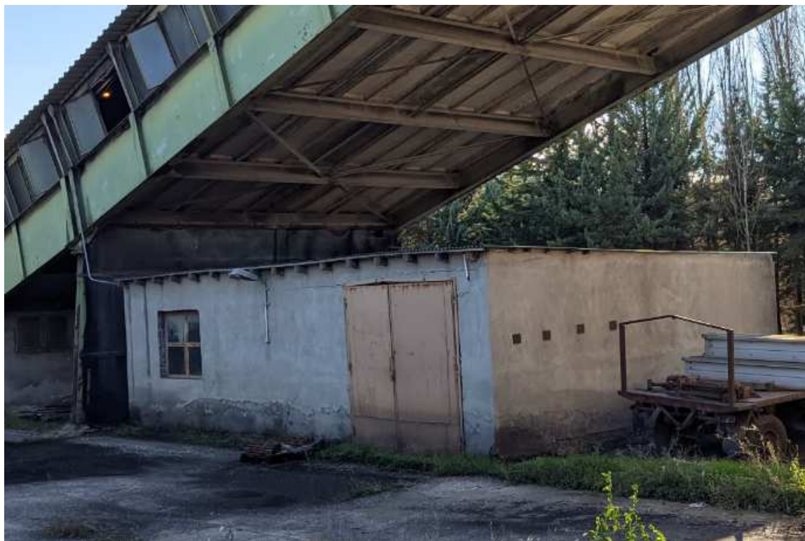
Εικόνα 5-109: Κτήριο Δειγματοληψίας Λιγνίτη & Αποδυτήρια Υ3.3
