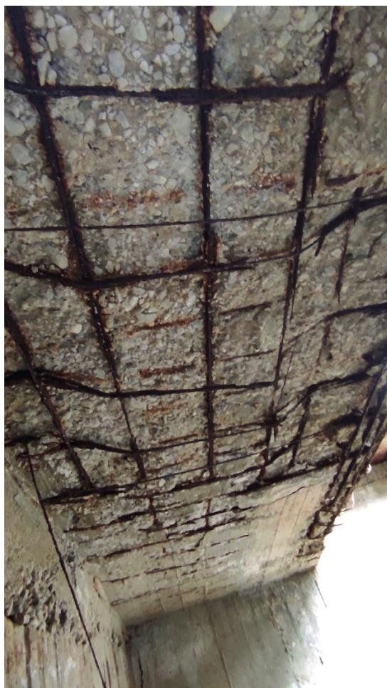
Φωτογραφία 16 Άποψη φρεατίου άντλησης νερού ψύξεως – πλήρης διάθρωση οπλισμού πλάκας οροφής και πλήρης αστοχία επικάλυψης σκυροδέματος.
