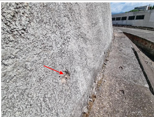
Εικόνα 5: A04 – Τοιχοποιία (Εξωτερικά) / Πύργος Ψύξης Μονάδας I
