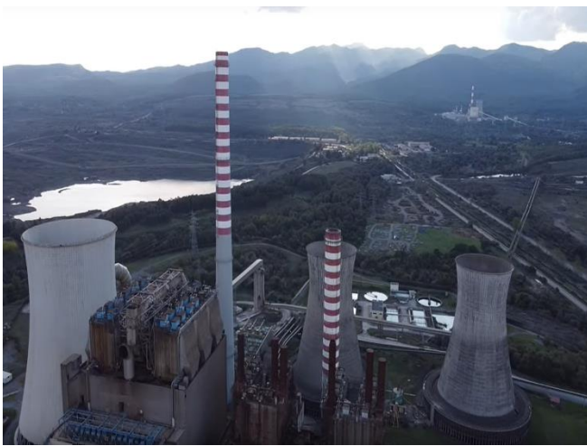
Εικόνα 1: Εξωτερική όψη Πύργων Ψύξης Μονάδων I-III
