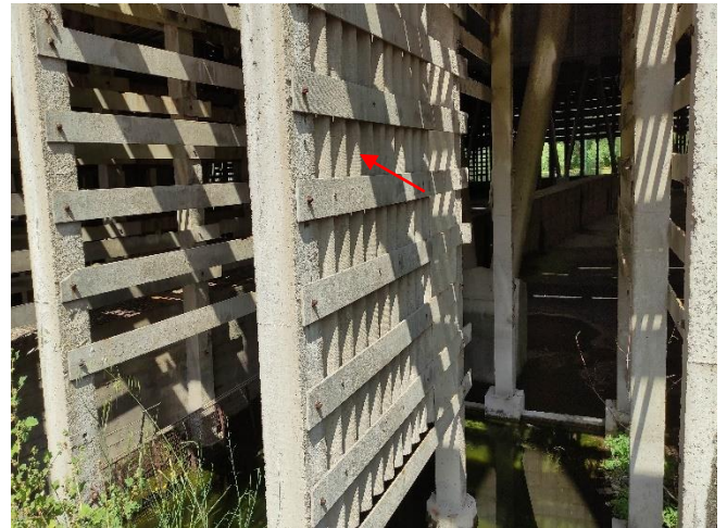
Εικόνα 4: A03 – Κυματοειδές Φύλλο / Πύργος Ψύξης Μονάδας I
