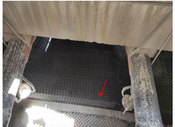
Εικόνα 10: A09 – Πτερύγια Κάτω Στρώμα Πακέτου / Πύργος Ψύξης Μονάδας III
