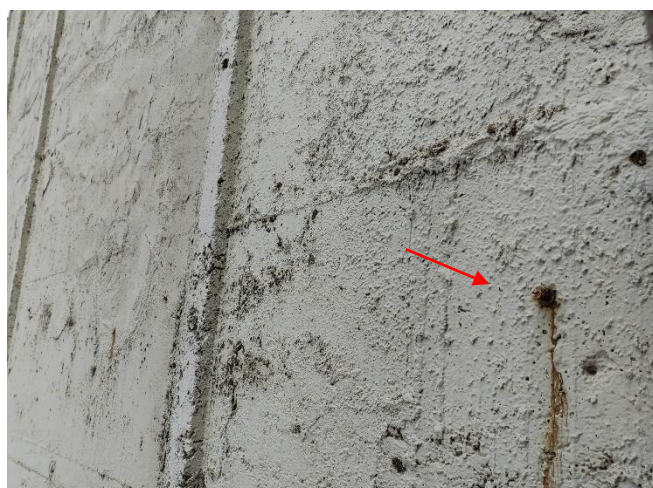
Εικόνα 16: A15 – Τοιχοποιία (Εξωτερικά) / Πύργος Ψύξης Μονάδας II
