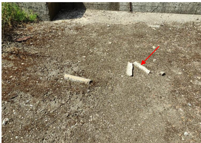
Εικόνα 21: Πύργος Ψύξης ΙΙ – Θραύσματα περιμετρικά
