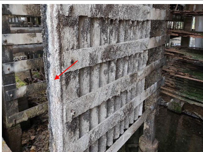
Εικόνα 17: A16 – Κολώνες Στήριξης / Πύργος Ψύξης Μονάδας II
