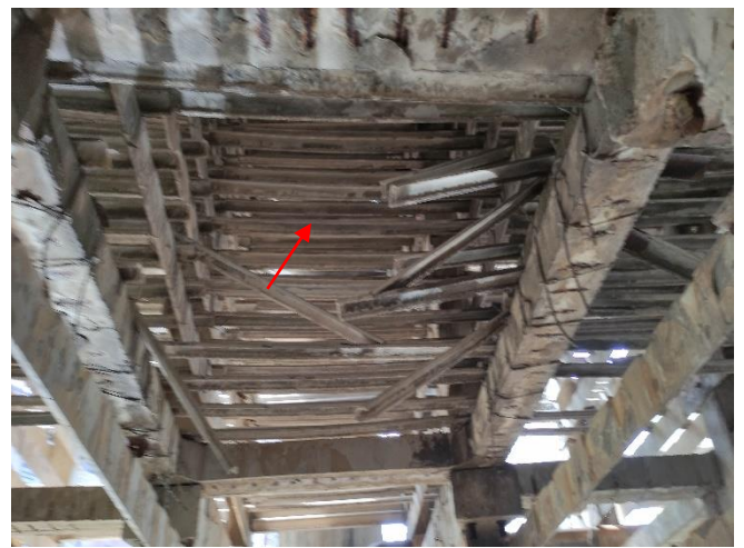
Εικόνα 2: A01 – Οριζόντιοι Διαχύτες Νερού (Καμπυλοειδή) / Πύργος Ψύξης Μονάδας I
