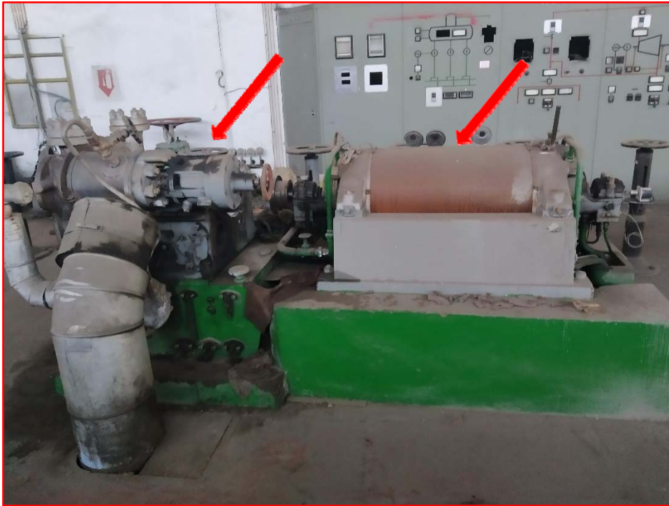
Εικόνα 10 – 11: (Μηχανοστάσιο – κτίριο 2b – επίπεδο +5,50μ.) – Τροφοδοτική αντλία λέβητα (2 τεμ). Υπάρχουν δύο αντλίες στο χώρο του μηχανοστασίου οι οποίες έχουν αμιαντούχα υλικά. Η μελέτη και δειγματισμός των υλικών πραγματοποιήθηκε στην τρίτη αντλία που υπάρχει στο χώρο και καταγράφηκαν στην μελέτη «ΕΝΤΟΠΙΣΜΟΣ ΚΑΙ ΚΑΤΑΓΡΑΦΗ ΑΜΙΑΝΤΟΥ ΚΑΙ ΑΜΙΑΝΤΟΥΧΩΝ ΥΛΙΚΩΝ ΣΕ ΗΛΕΚΤΡΟΜΗΧΑΝΟΛΟΓΙΚΟ ΕΞΟΠΛΙΣΜΟ ΠΡΩΗΝ ΕΝΕΡΓΕΙΑΚΟΥ ΣΥΓΚΡΟΤΗΜΑΤΟΣ ΛΙΠΤΟΛ. & ΣΥΝΤΑΞΗ ΤΕΥΧΟΥΣ ΤΕΧΝΙΚΗΣ ΠΡΟΔΙΑΓΡΑΦΗΣ ΑΠΟΡΡΥΠΑΝΣΗΣ ΕΞΟΠΛΙΣΜΟΥ» με συντάκτη τον Χρήστο Δ. Γανδά.
