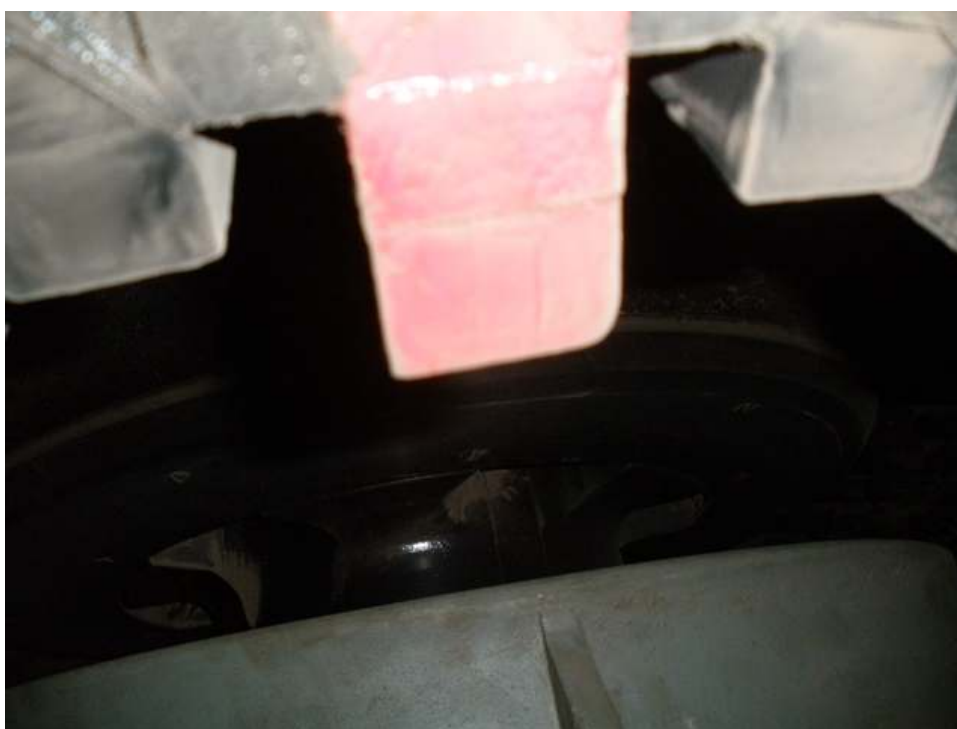
Φωτ. 35. Αποσυναρμολόγηση συνδέσμου (coupler) στροβίλου - γεννήτριας.
