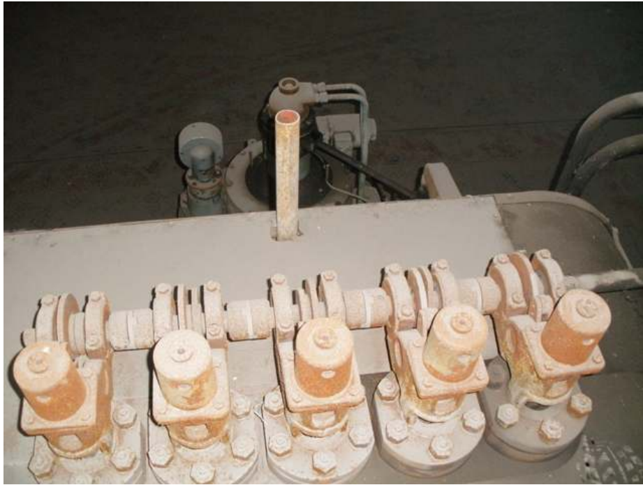
Φωτ. 27. Ρυθμιστικές βαλβίδες ατμοστροβίλου. Η αποσυναρμολόγηση θα γίνει συνολικά μαζί με τον άξονα.
