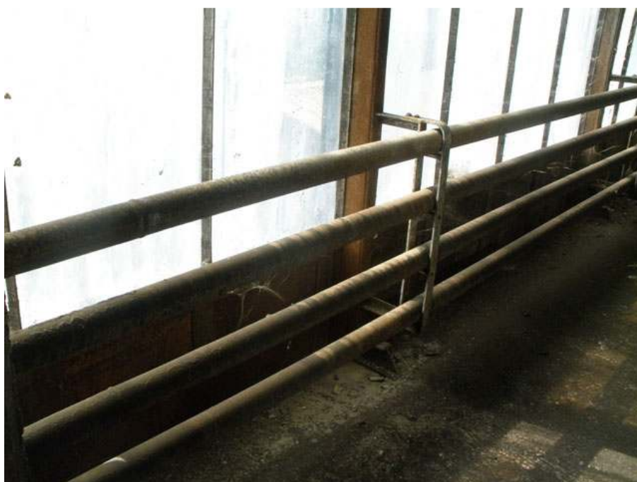
Φωτ. 56. Γαλοστάσιο ΝΑ όψη. Λεπτομέρεια δικτύων. Περιοχή καθέραισης.
