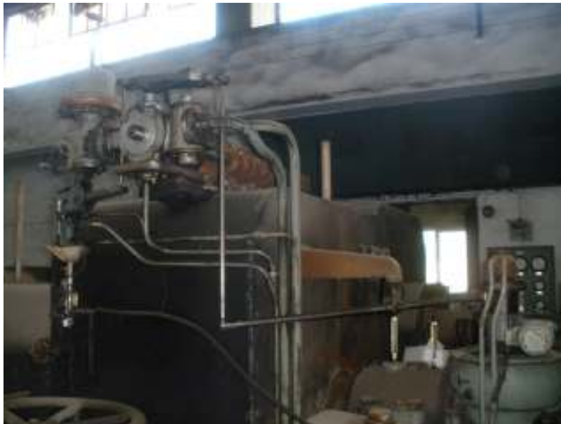
Φωτ. 22. Συνολική διάταξη του ρυθμιστή ισχύος. Αριστερά το στοιχείο ρύθμισης αντιτίεσης, στο κέντρο, με το μοιρογνωμόνιο, ο γωνιακός κινητήρας ρύθμισης ισχύος του στροβίλου, δεξιά το φυγοκεντρικό στοιχείο. Μεταξύ κεντρικού και δεξιού στοιχείου η αρθρωτή ράβδος «Γ» που μεταδίδει την εντολή του φυγοκεντρικού στοιχείου στον κινητήρα του ρυθμιστή.
