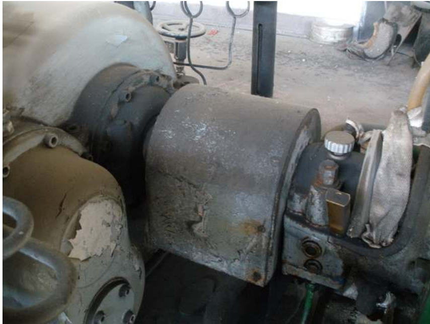
Φωτ. 12 . Κάλυμμα συνδέσμου (coupler) στροβίλου – αντλίας
