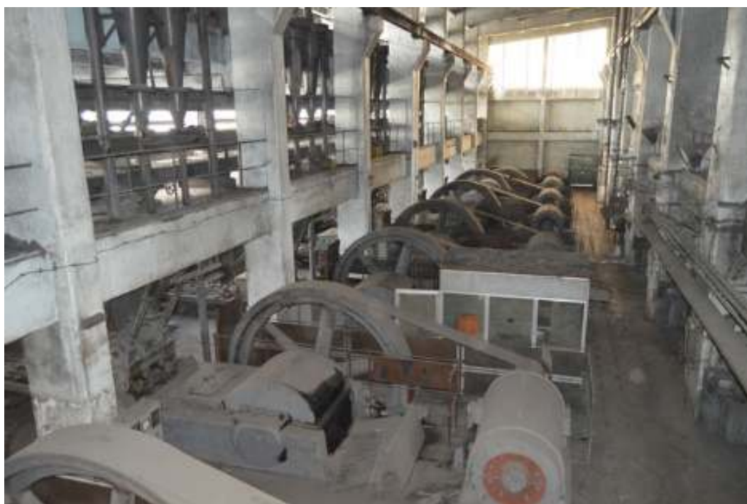
Φωτ. 119. Χώρος πιεστηρίων.
