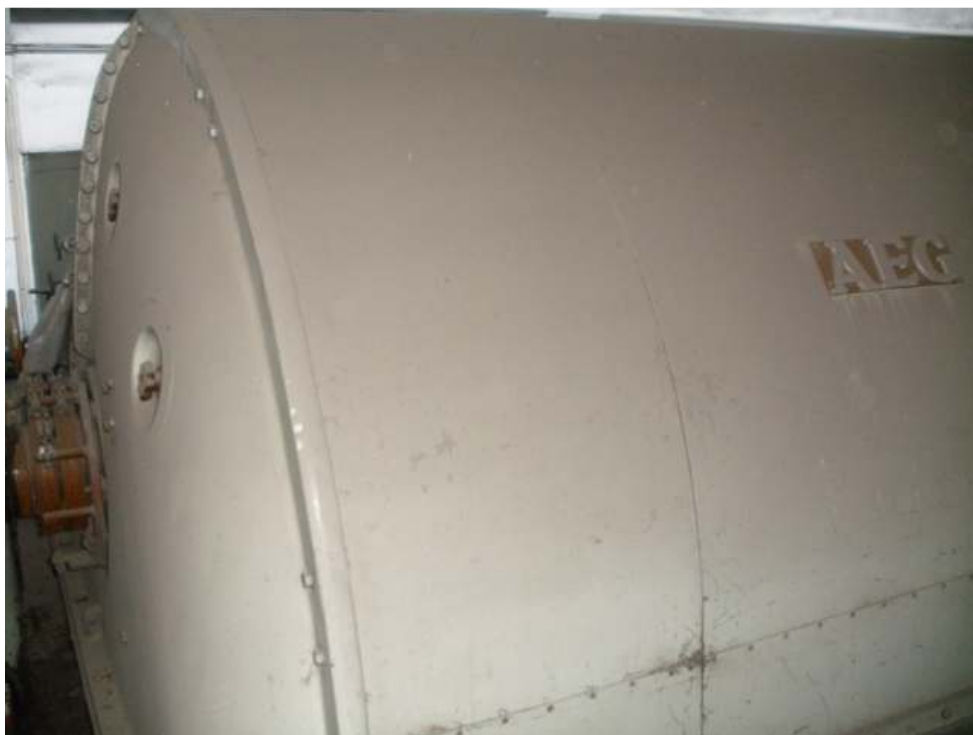
Φωτ. 34. Αποσυναρμολόγηση του καλύμματος της γεννήτριας.
