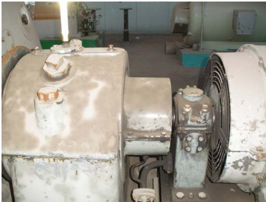
Φωτ. 30. Αποσυναρμολόγηση τριβέα γεννήτριας.
