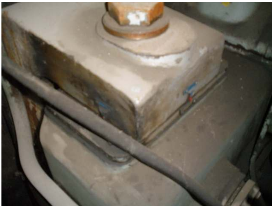
Φωτ. 38. Αποσυναρμολόγηση κοχλιών των πεδίων στήριξης του στροβίλου.
