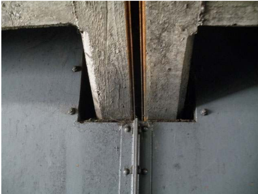
Φωτ. 95. Κόσκινο φυσικού λιγνίτη. Κάτω τμήμα, λεπτομέρεια της χοάνης γύρω από την δοκό.
