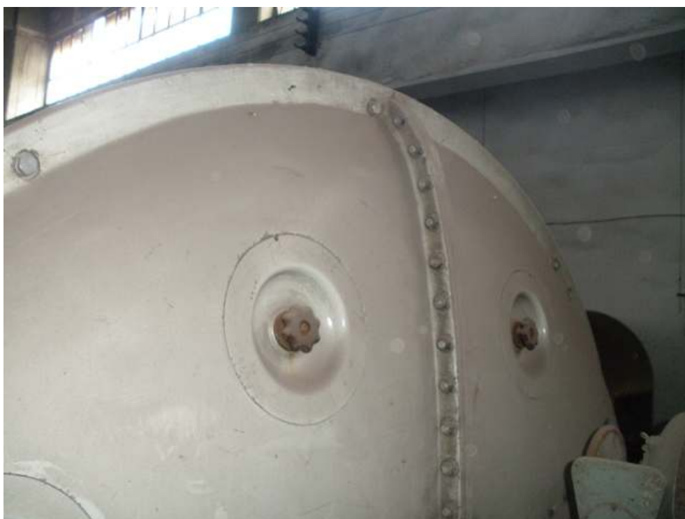
Φωτ. 34. Αποσυναρμολόγηση του καλύμματος της γεννήτριας.
