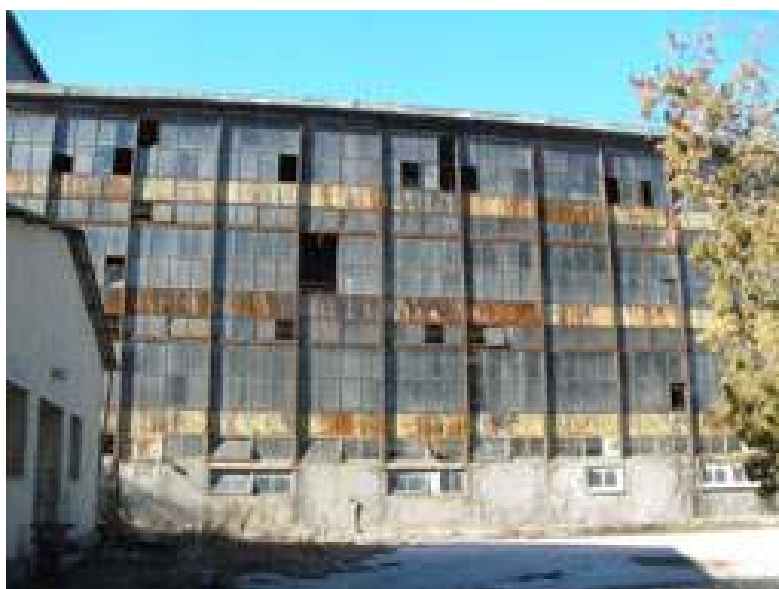
Φωτ. 54. Υαλοστάσιο νοτιοανατολική εξωτερική όψη.
