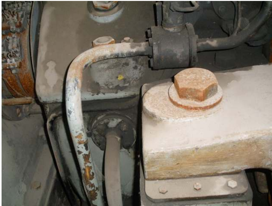
Φωτ. 31. Αποσυναρμολόγηση καβαλέτου ενδιάμεσου τριβέα (Μεταξύ στροβίλου γεννήτριας). Προσοχή η αποσυναρμολόγηση αφορά μόνο στο καβαλέτο, το βασικό τμήμα του τριβέα θα παραμείνει στην θέση του μέχρι την εξάρμωση του τυμπάνου του στροβίκου. Προηγείται η αποσυναρμολόγηση του δικτύου λίπανσης και των καλωδιώσεων στις ψύκτρες διέγερσης της γεννήτριας. Σε πρώτο πλάνο διακρίνεται το εξάγωνο του κοχλία βάσεως του στροβίλου.
