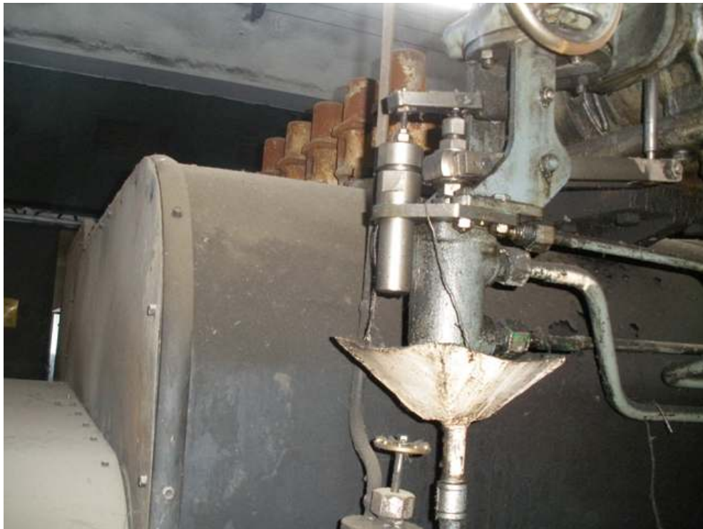
Φωτ. 37. Αποσυναρμολόγηση του κελύφους του στροβίλου.
