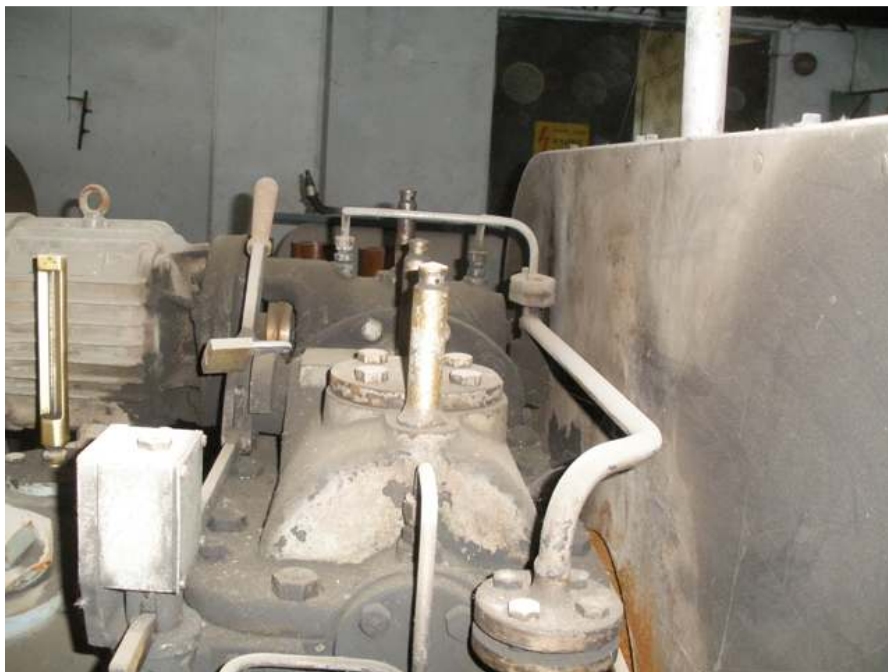
Φωτ. 28. Μηχανισμός του κρίκου. Ο ηλεκτροκινητήρας στηρίζεται κυρίως πάνω στον γωνιακό μειωτήρα του κρίκου. Τα δίκτυα αφορούν μόνο στην λίπανση των εδράνων.
