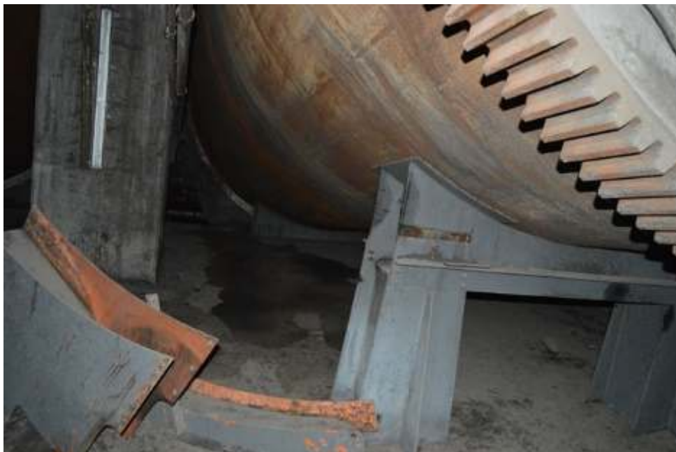
Φωτ. 115. Κατώτερη στάθμη (-1). Διακρίνονται τα στηρίγματα βοηθητικής χρήσης.
