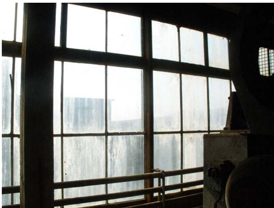
Φωτ. 55. Γαλοστάσιο ΝΑ όψη. Περιοχή καθέραισης.
