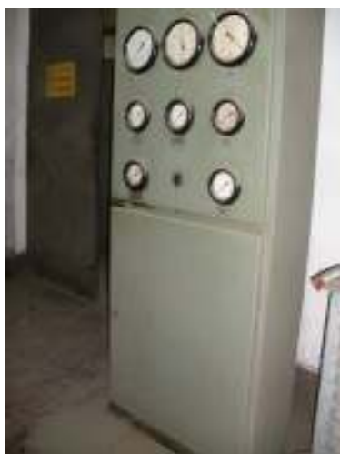
Φωτ. 43. Πίνακας ελέγχου βασικών λειτουργιών του στροβίλου.
