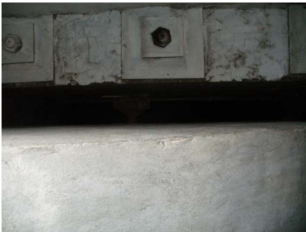
Φωτ. 36. Αποσυναρμολόγηση και καθαίρεση της βάσεως και «κάτω» κελύφους του στάτη της γεννήτριας. (Έχει προηγηθεί η ανύψωση του ρότορα και η αποσυναρμολόγηση των καλωδιώσεων του στάτη). Στην φωτ. διακρίνονται οι κοχλίες και τα περικόχλια συγκράτησης του πλαισίου της βάσης όπως φαίνονται από τον υπόγειο χώρο.
