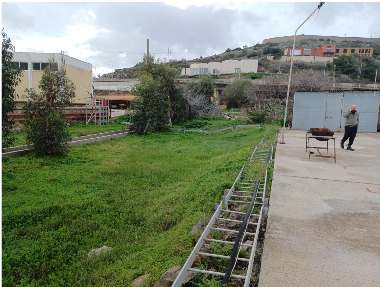
Εικόνα 2: Χώρος κατασκευής δεξαμενών (από Βορρά προς Νότο)
