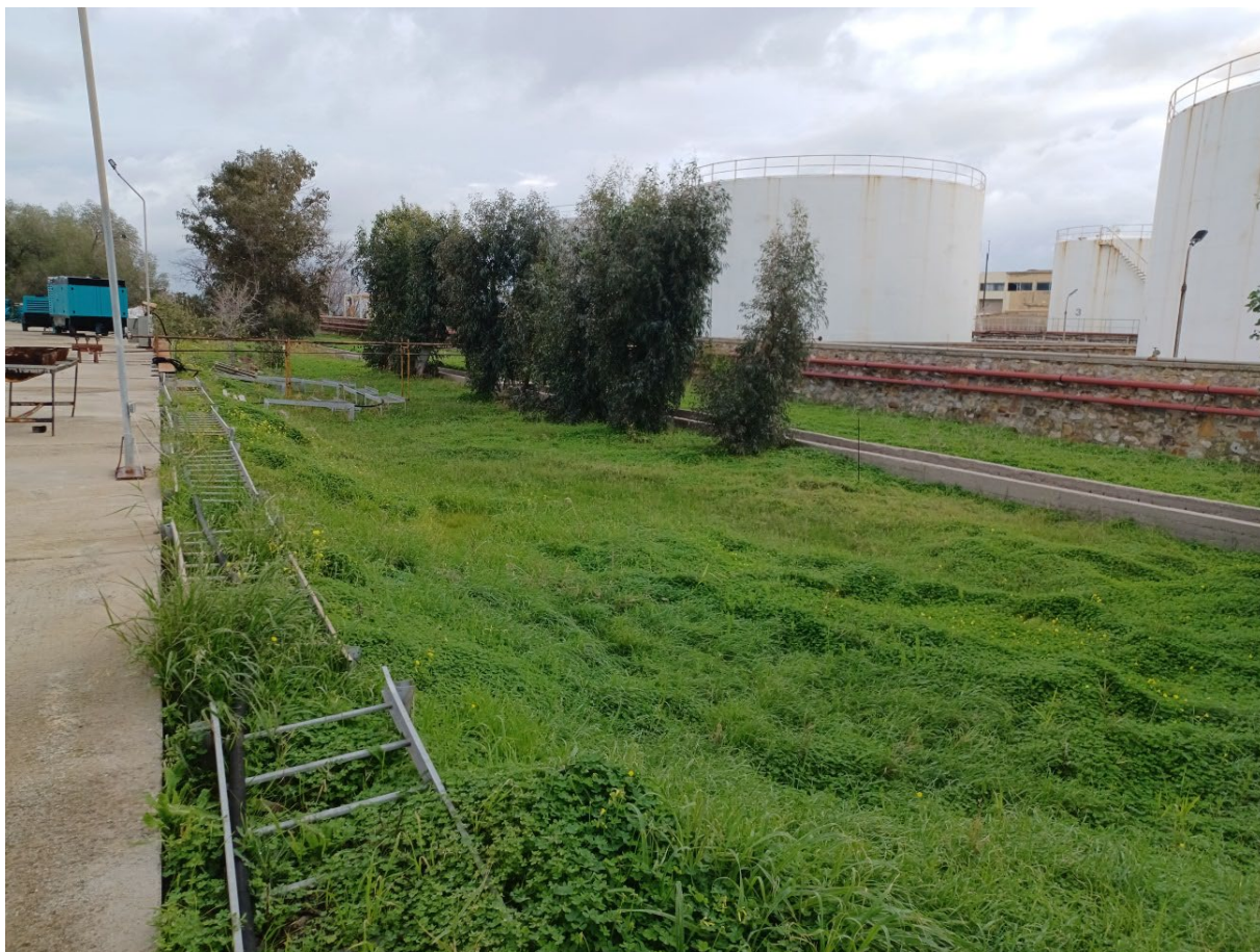
Εικόνα 1: Χώρος κατασκευής δεξαμενών (από Νότο προς Βορρά)
