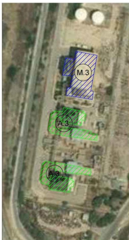
Εικόνα 4-3 Αεροφωτογραφία γενικής διάταξης της μονάδας IIII,
