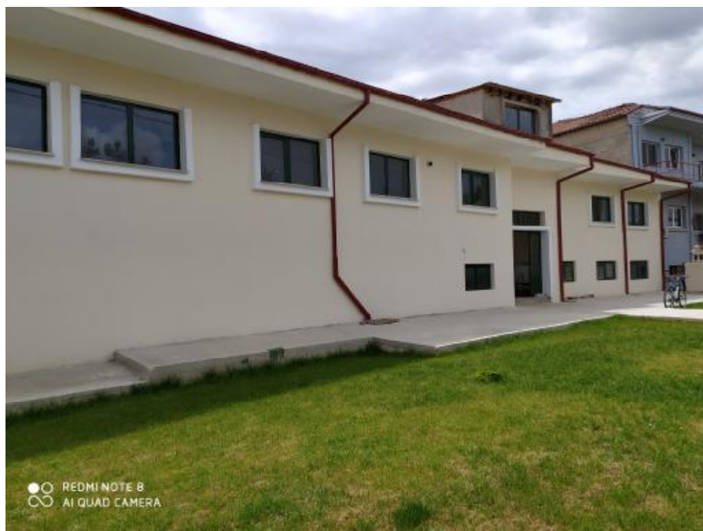
Βόρεια όψη κτιρίου
